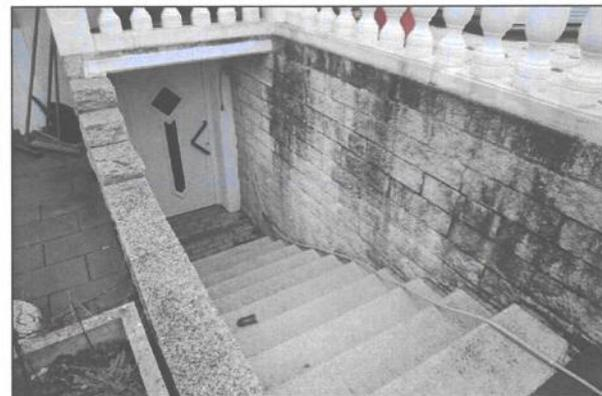
Bild 32: Unterhaltungsstau/Schäden (Beispiel)
