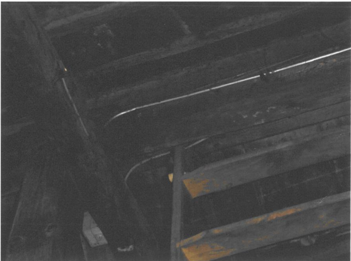
Dachansicht von Innen, Camberger Straße 51, Hülfelden-Ohren
