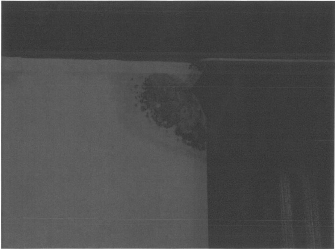
Schimmelbildung in einem Wohnraum, Camberger Straße 51, Hülfelden-Ohren
