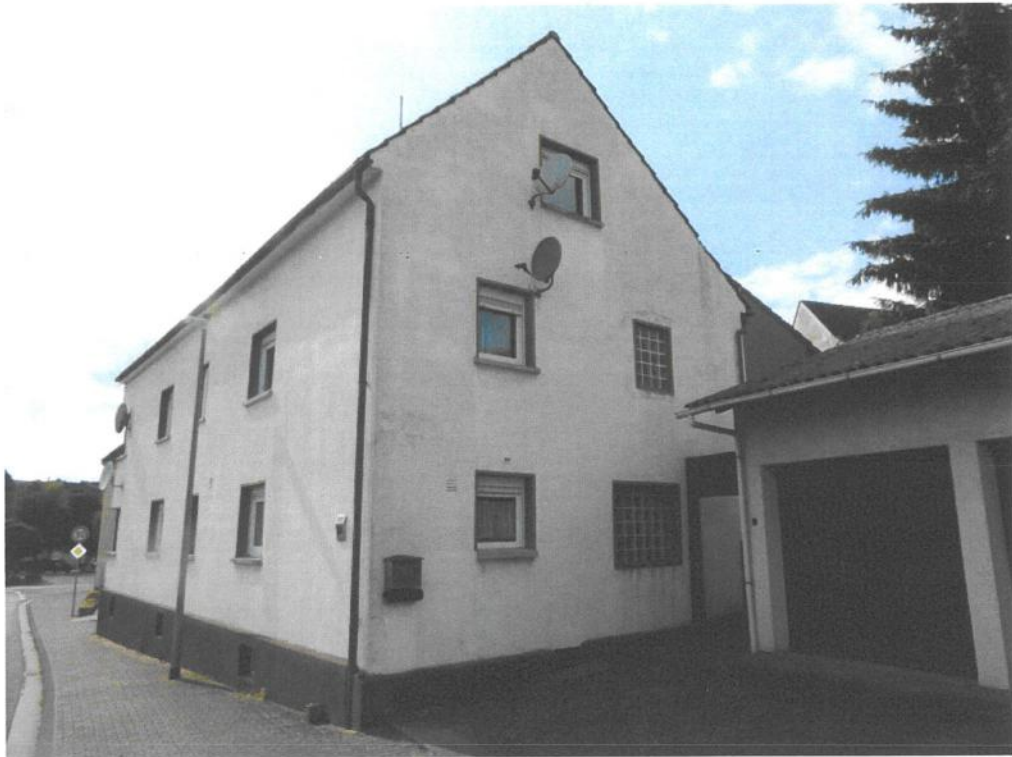
Haus Camberger Straße 51, Hünfelden-Ohren, Straßenansicht
