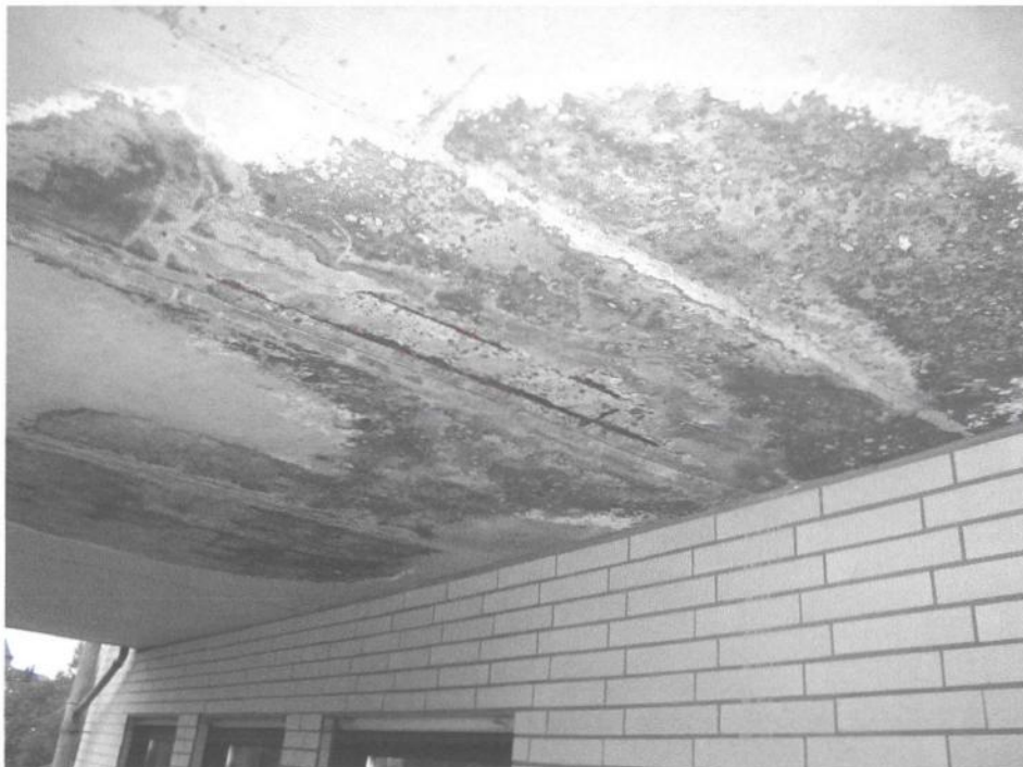
Foto Nr. 22: EG, Balkonunterseite, Feuchtigkeits- und Folgeschäden
