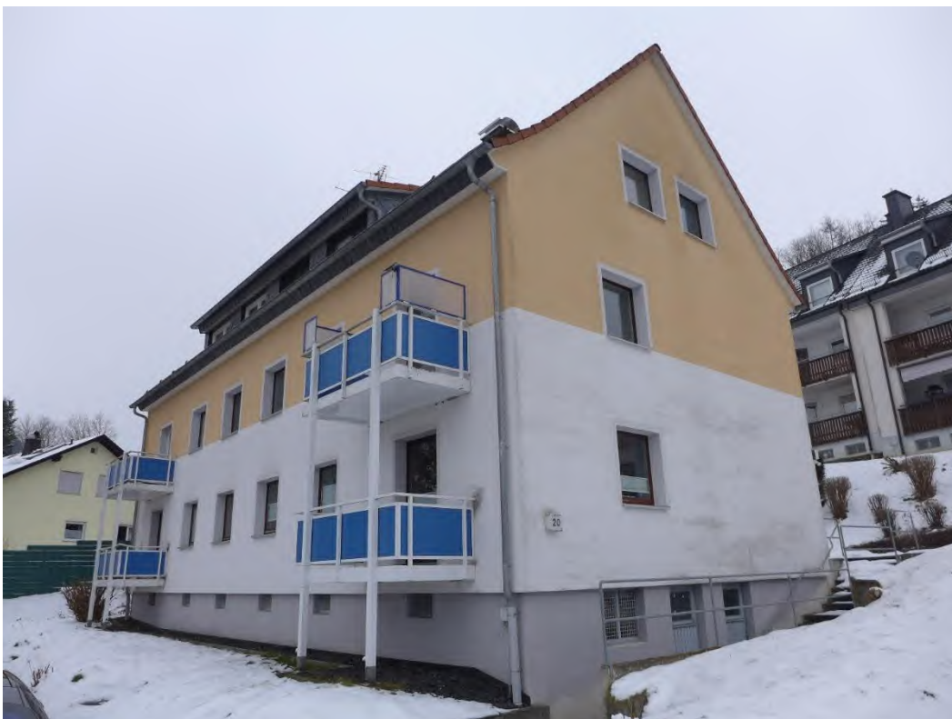
2 Gebäudeseiten- und Fassadenansicht (Südostansicht)
