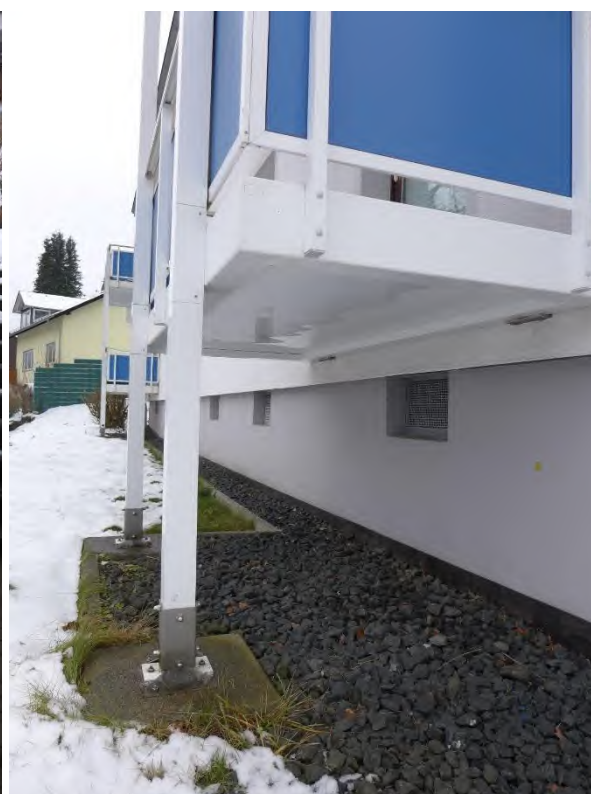
8 b erneuerte Balkonanlage
