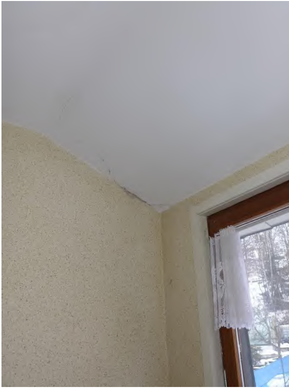
13 a Rissbildung Dachgeschoss Treppenhaus 13 b Oberlichter Treppenhaus
