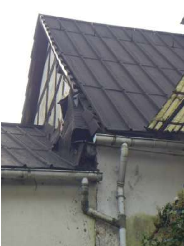
11 a schadhafter Ortgang Hauptdach
