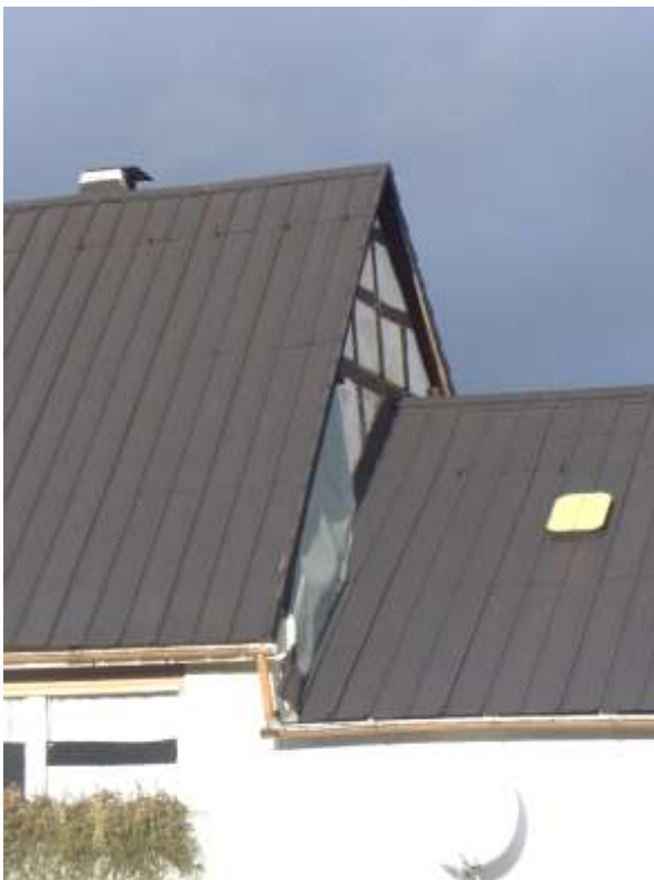
16 a mangelhafter Dachanschluss zur Garage 16 b Detail Holzteil im Dachbereich,
