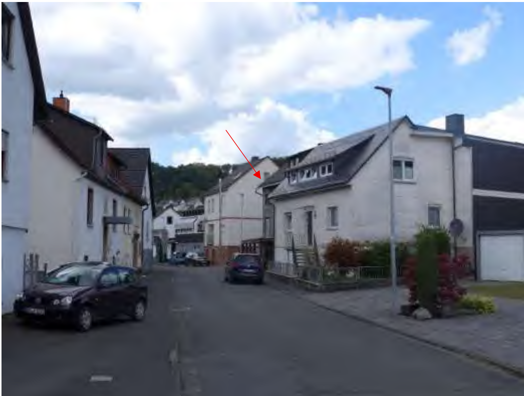
1 Lage des Wohnhauses in der Straße, Umgebungsbebauung
