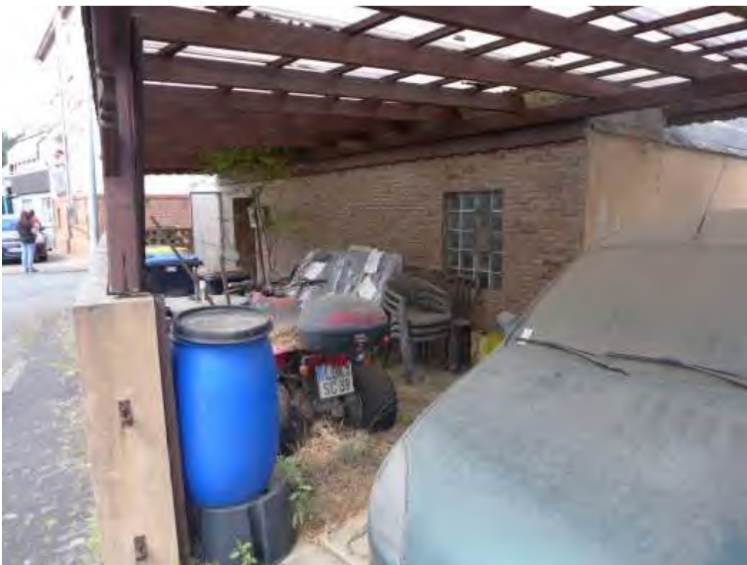
6 Carport und angebaute Überdachung
