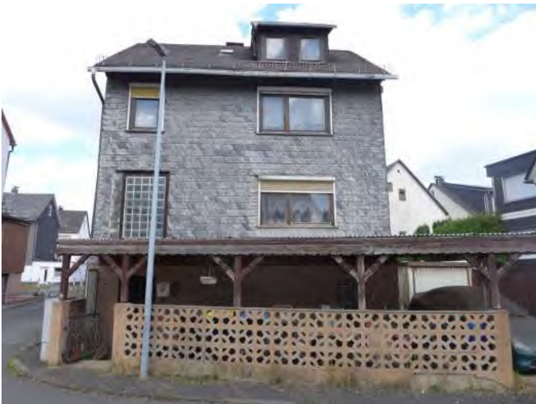
2 Frontansicht von der Hofstraße (Südansicht)
