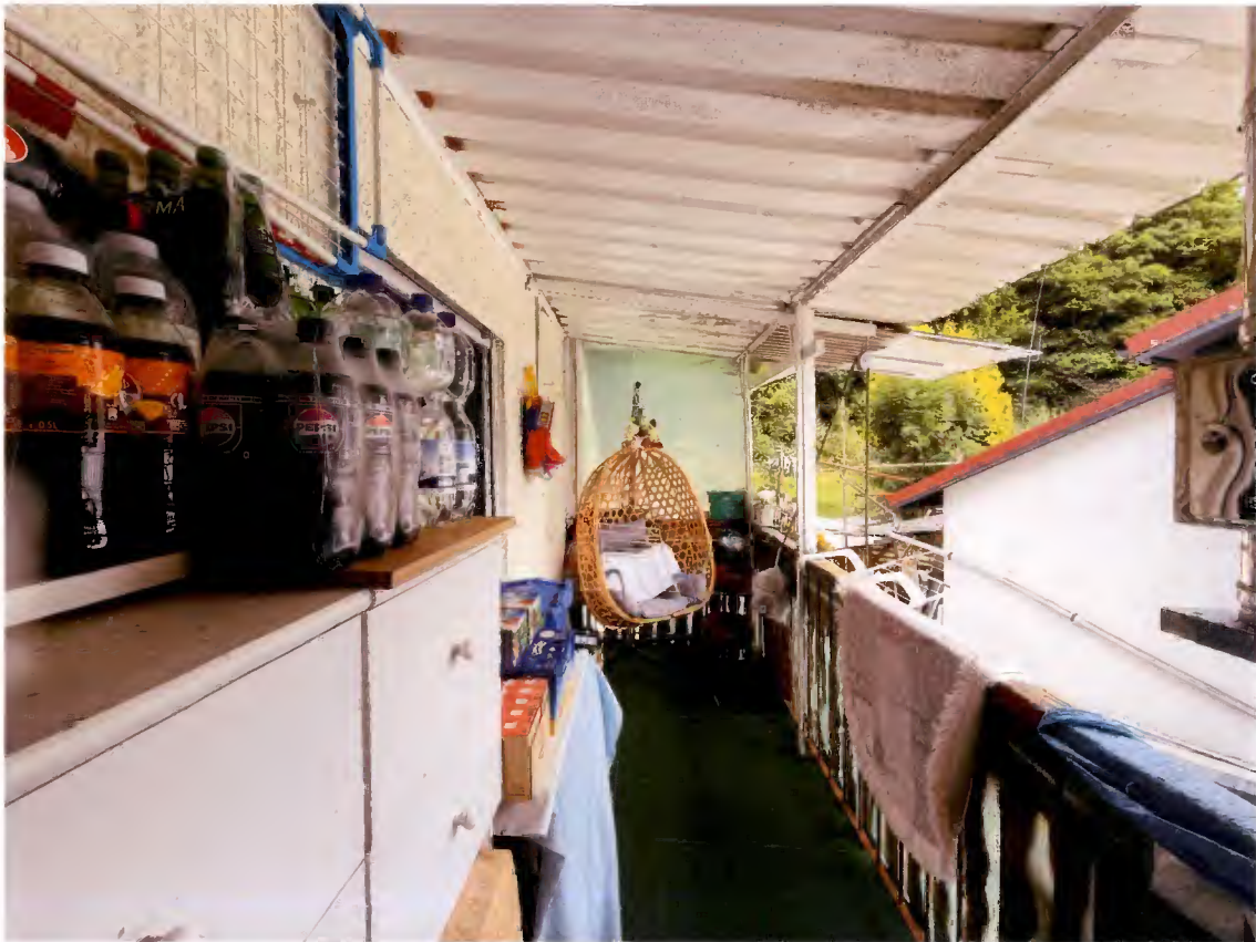
Foto 33 - Balkon Wohnung rechts OG
