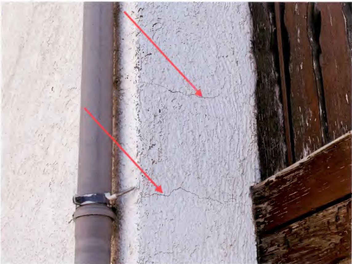
Foto 10 - Deckenschubrisse Südfassade
