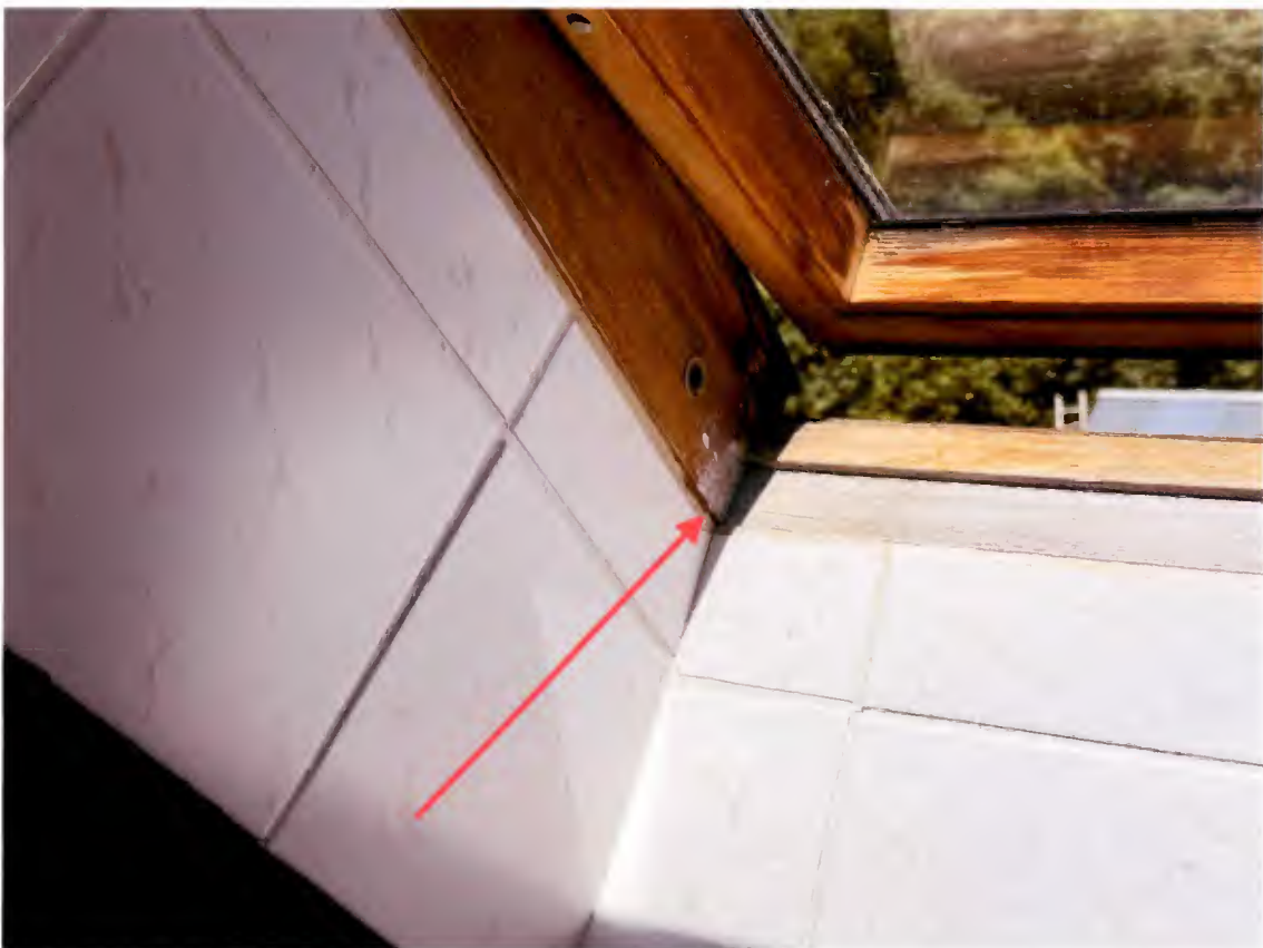
Foto 34 - Sanierungsbedarf Dachflächenfenster
