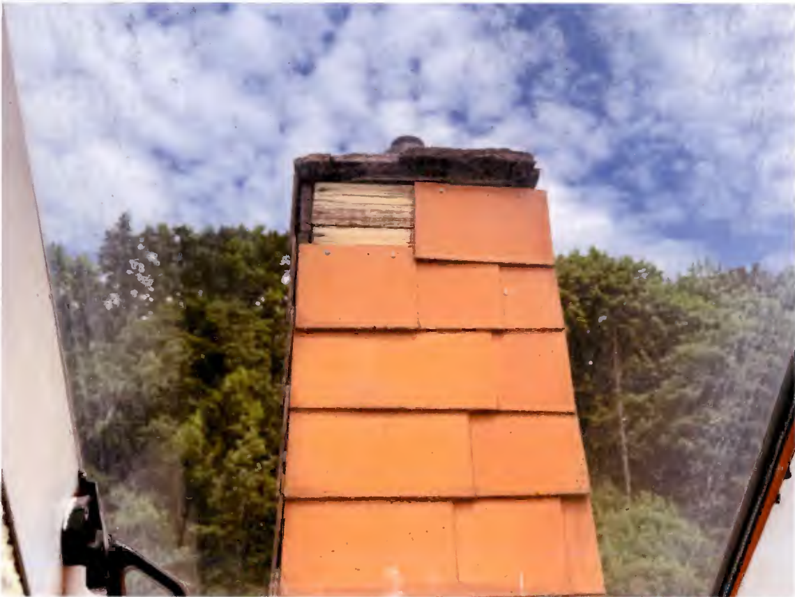
Foto 27 - Sanierungsbedarf Schornstein
