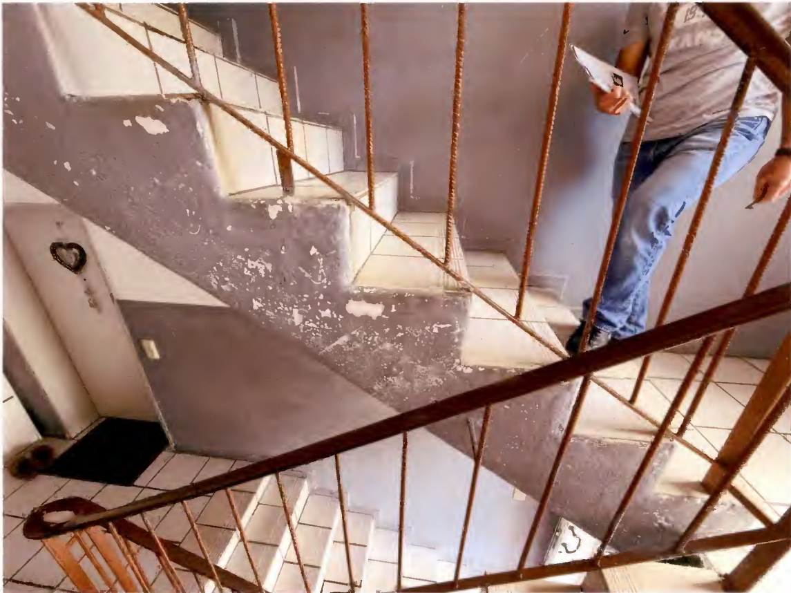
Foto 23 - Putzschäden Stahlbetontreppe
