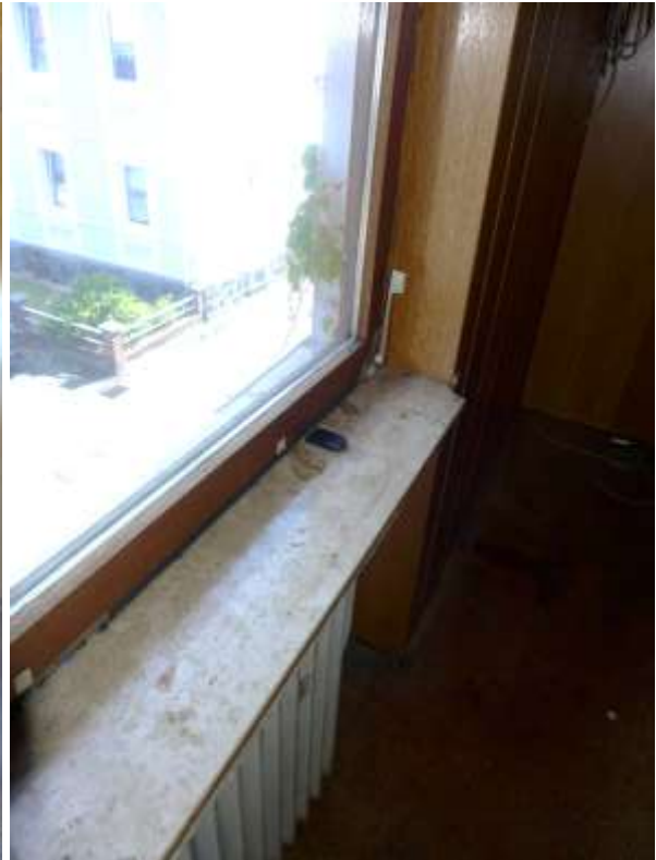
23 b Zustand Fenster Obergeschoss
