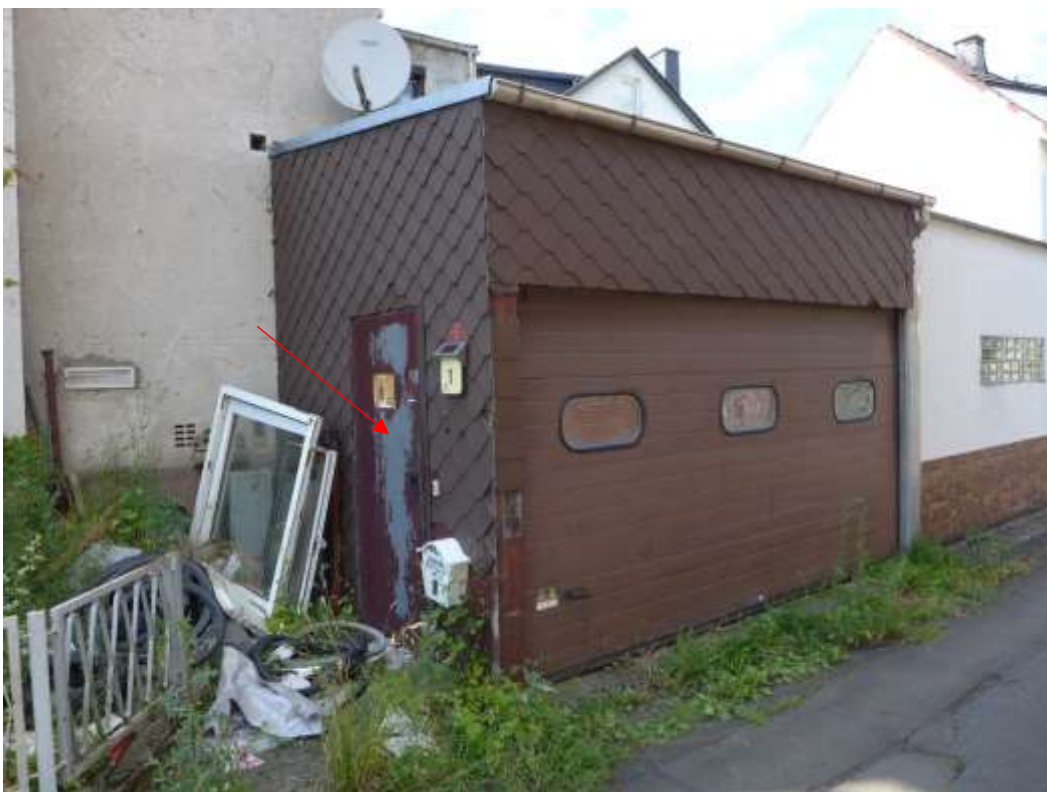
12 Garage und Wohnhauszugang links (Pfeil)
