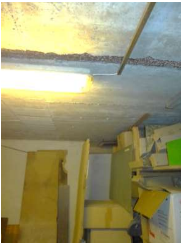
30 a Kellerdecke Anbau
