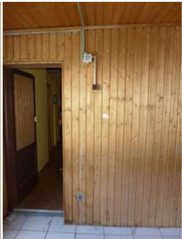
24 b Ausbau Obergeschoss, Leitungsführung
