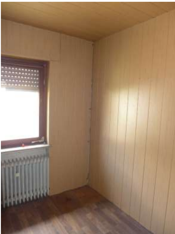
24 a Ausbau Obergeschoss
