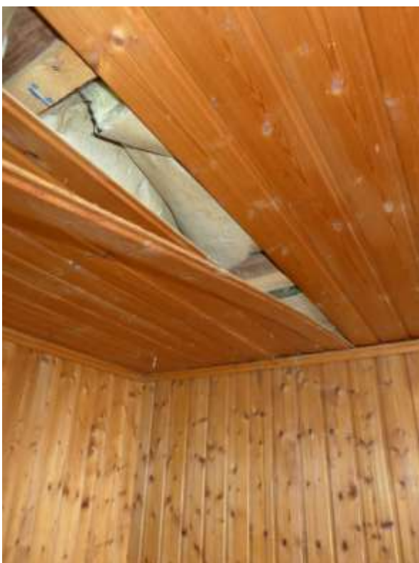
22 a Ausbau Obergeschoss
