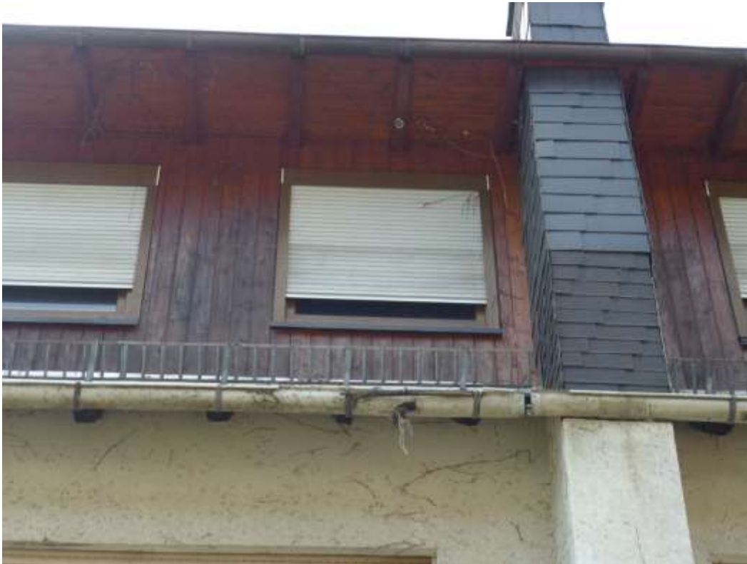
5 Fassade Bereich Gaube
