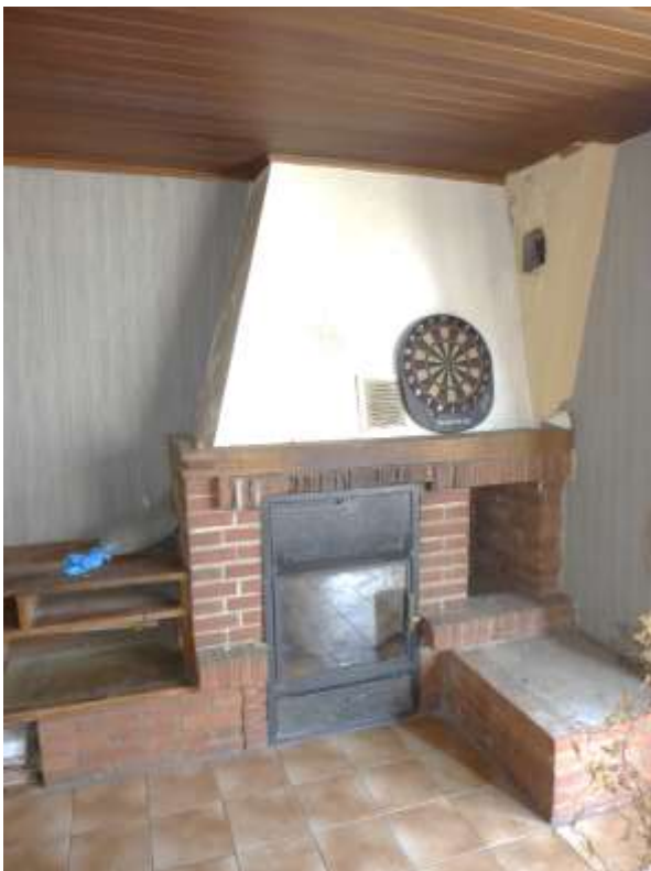
16 a Kamin Wohnzimmer Erdgeschoss
