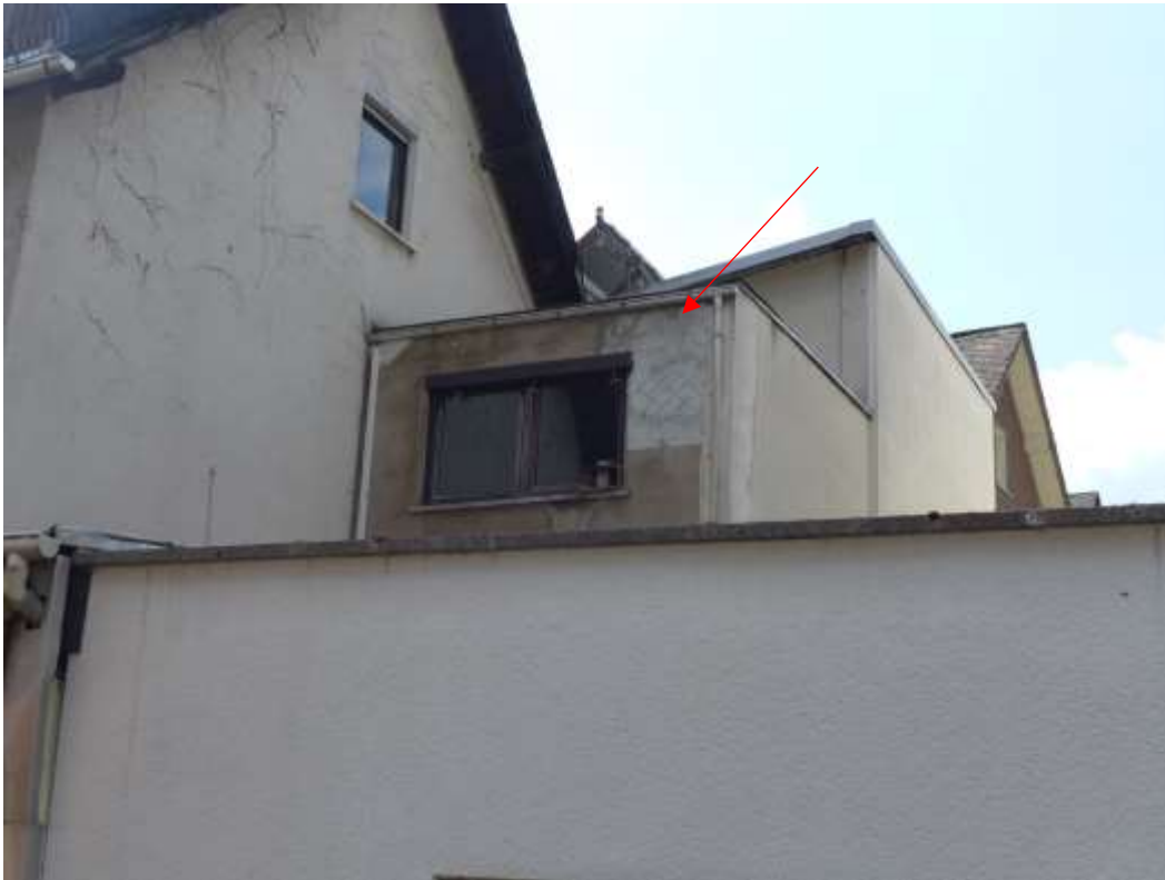
7 Fassade, Anbau (Pfeil)
