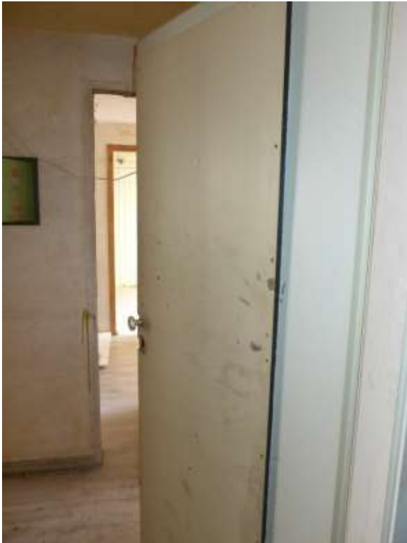
17 a Innentür Erdgeschoss
