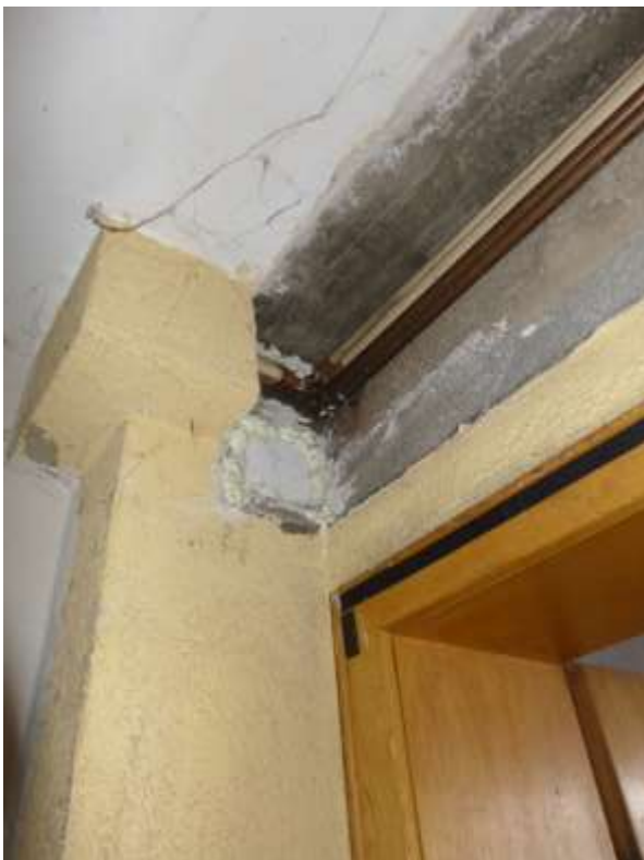
18 a Zustand Innenausbau Erdgeschoss
