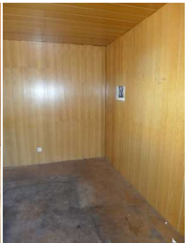
22 b Ausbau Zimmer Obergeschoss
