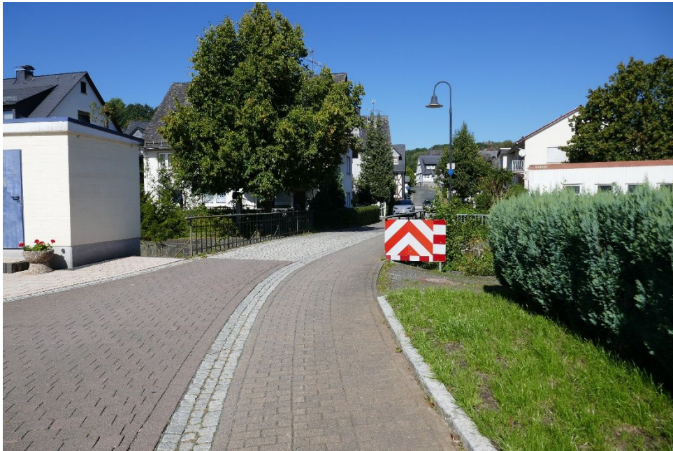
Bild_09_“Brücke über den Roßbach“
