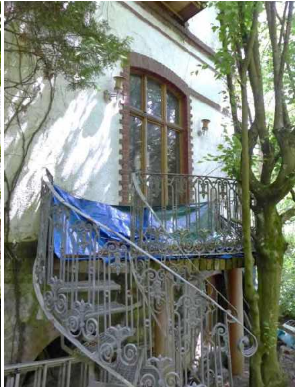
15b Treppe zum Balkon
