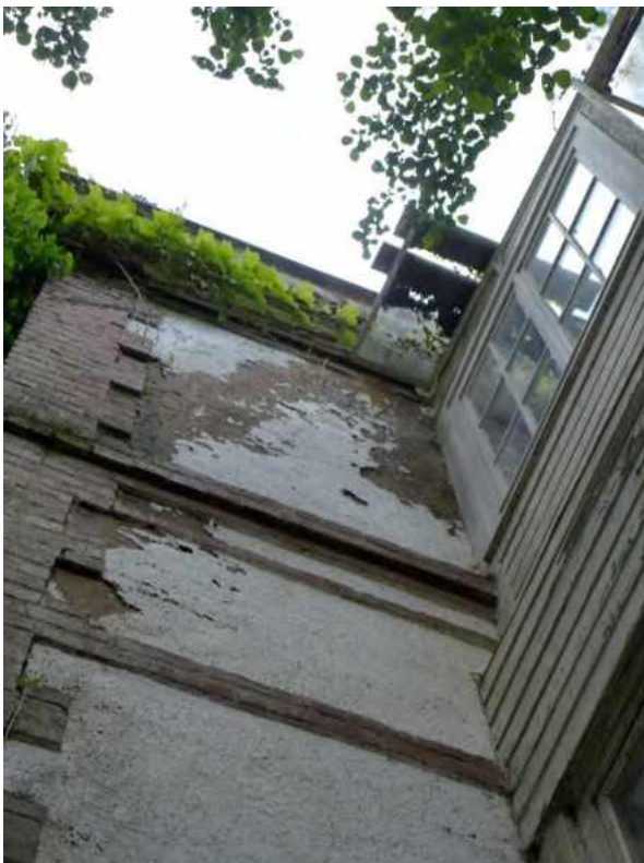
16 Fassaden-/Putzschäden
