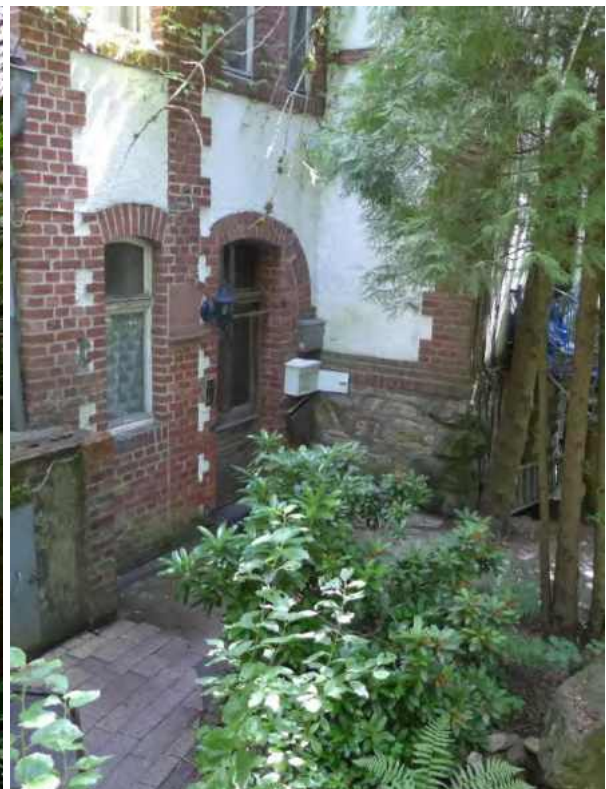
6 b Zugang zum Treppenhaus
