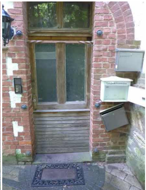
8 b Eingang Treppenhaus Südwestseite
