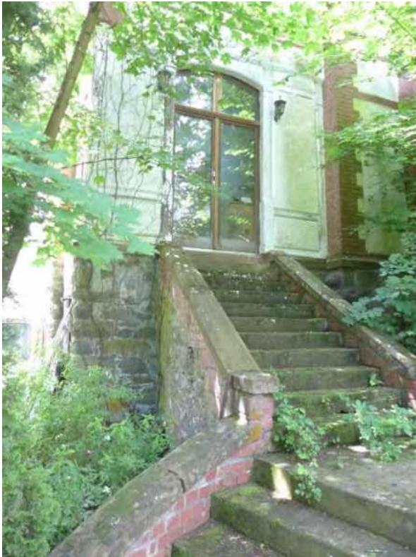
11 a Freitreppe Nordostseite
