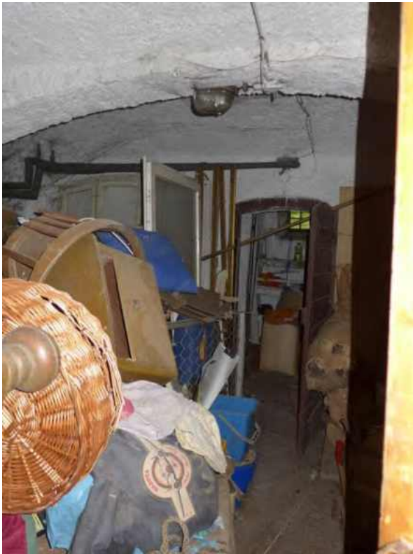
33 a Kellerräume (Foto 2019)
