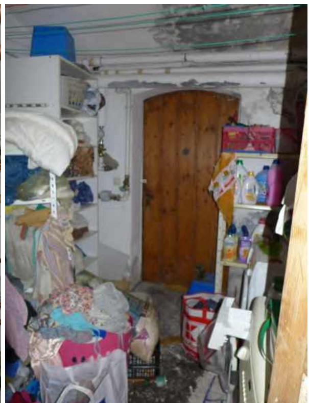
32 b Kellerraum (Foto 2019)
