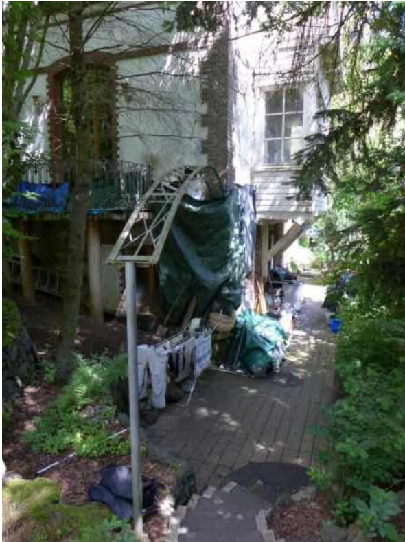
17 a Bereich Kellerzugang
