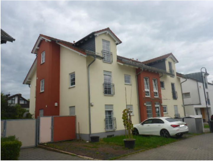
Ansicht von Nordosten
