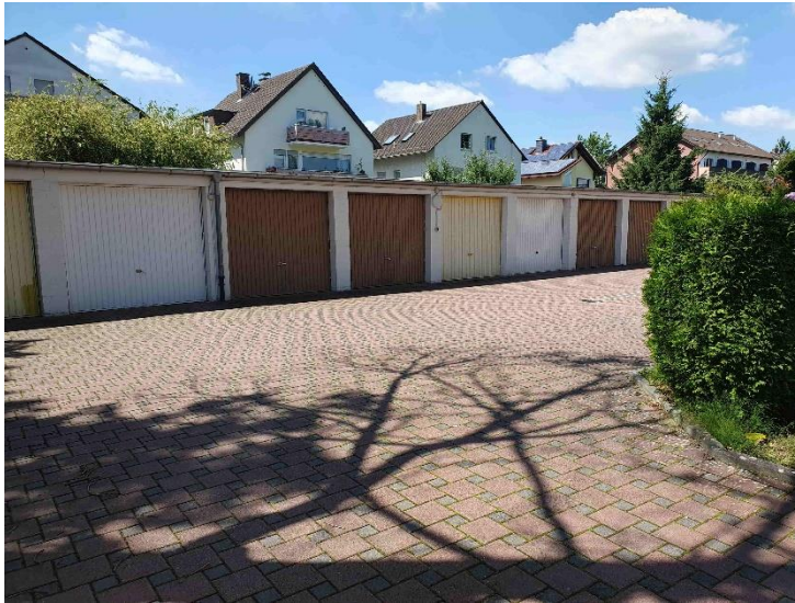
Ansicht von Osten - Garagen
