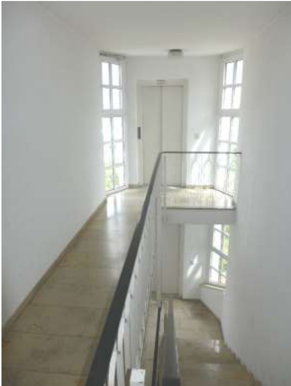
11 a Treppenhaus Nr. 10
