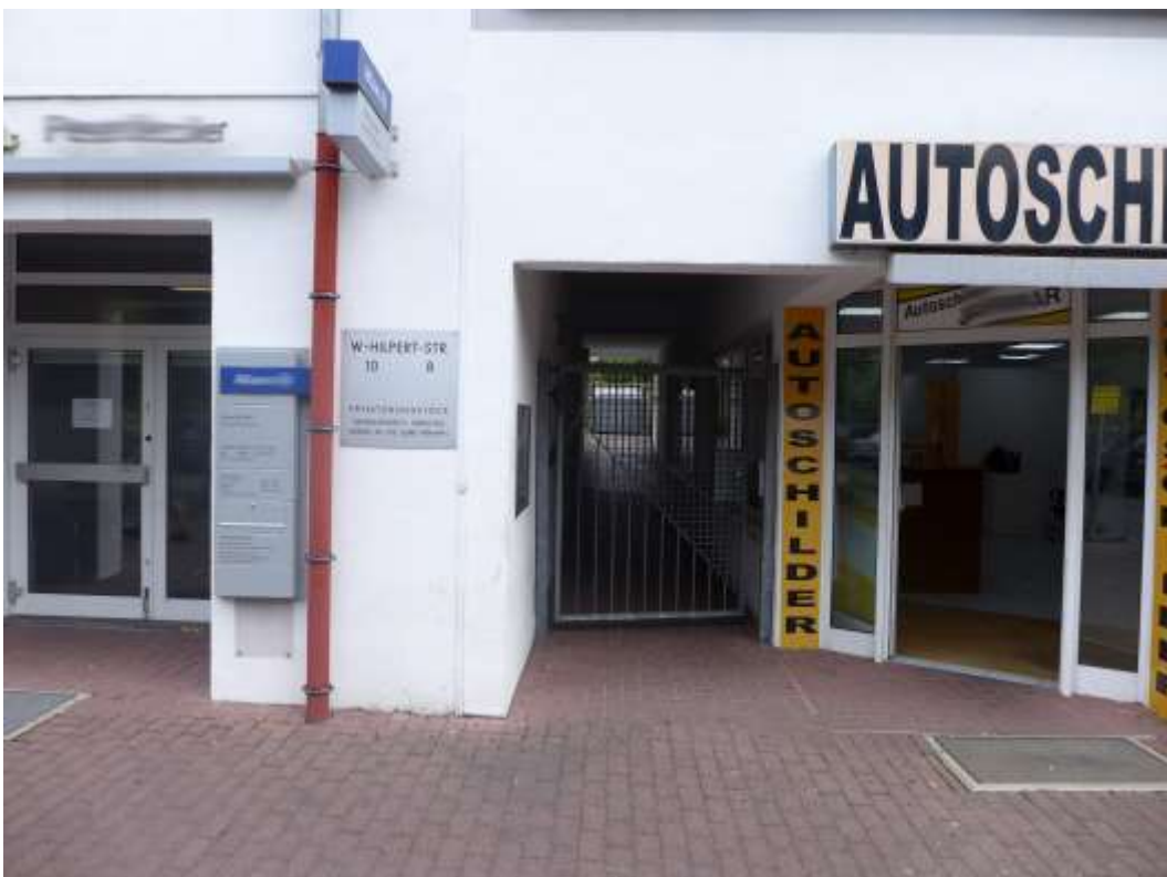
4 Zugang zu den Treppenhäusern
