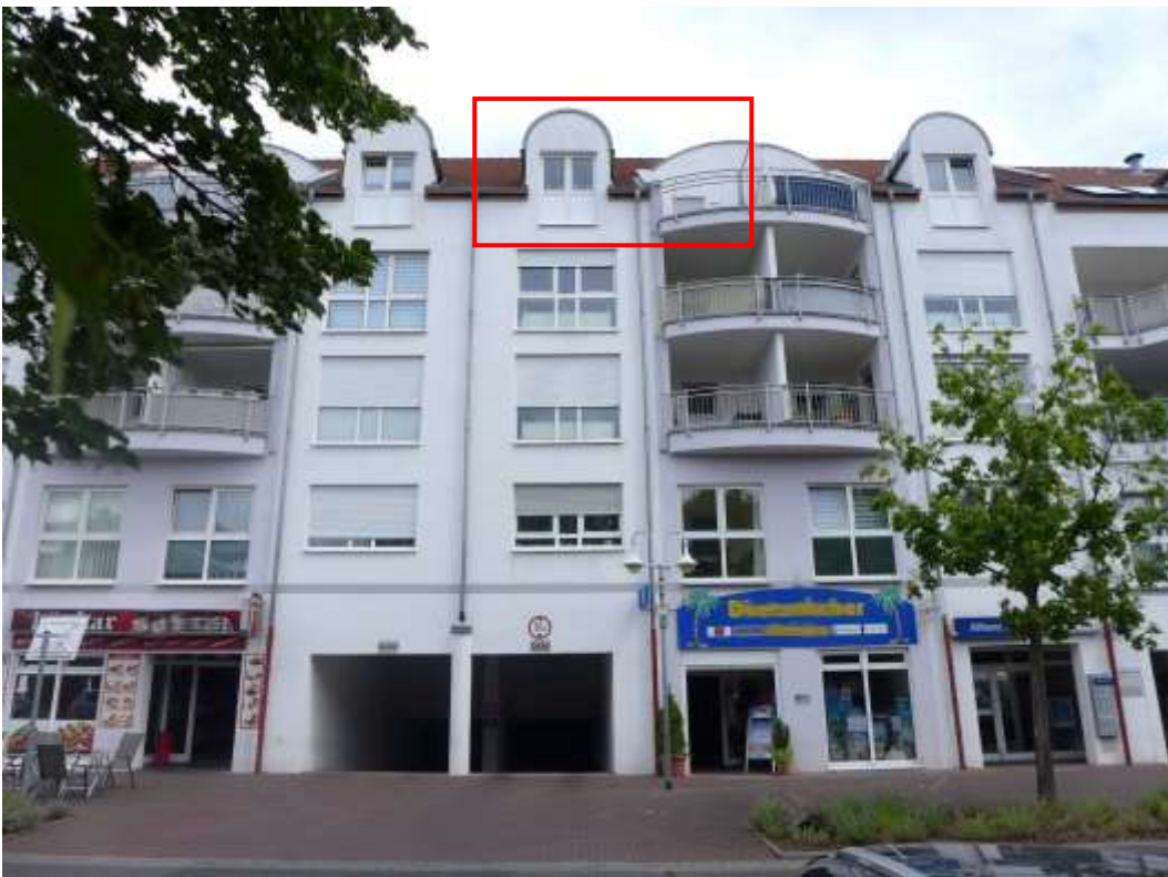
2 Straßenansicht, Lage des Objekts (Wohnung Nr. 44)
