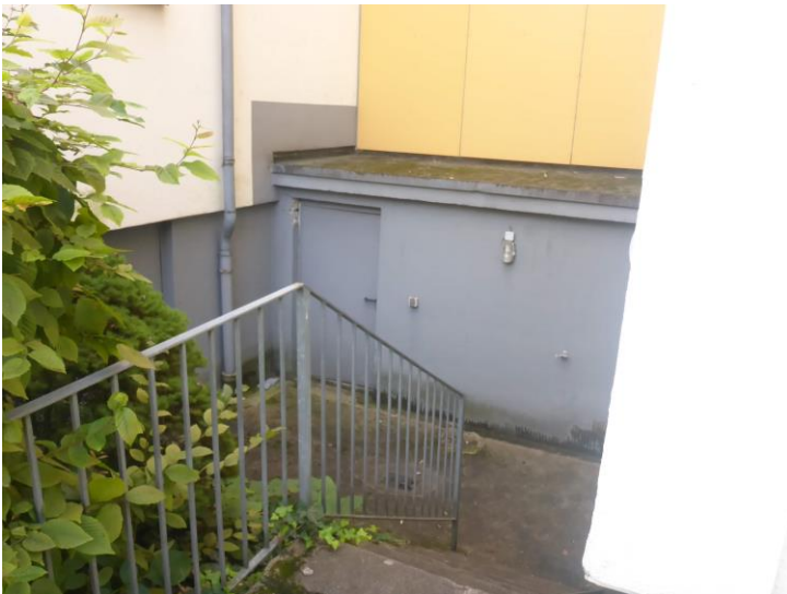
Außentreppe zum Kellerge- schoss
