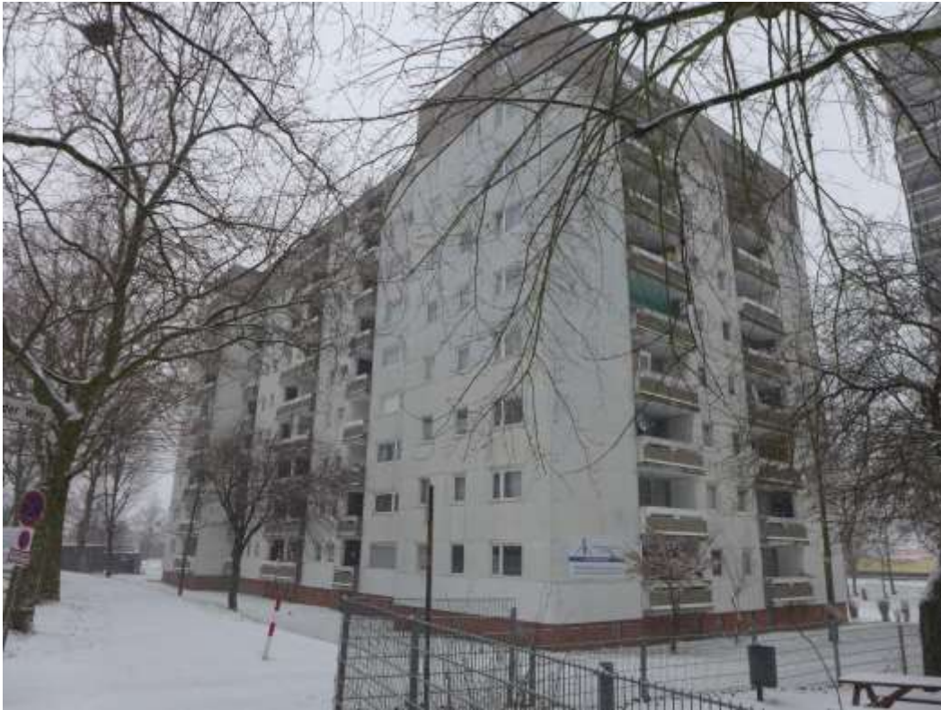
1 Straßenansicht Gebäude Wertheimer Weg 2-4
