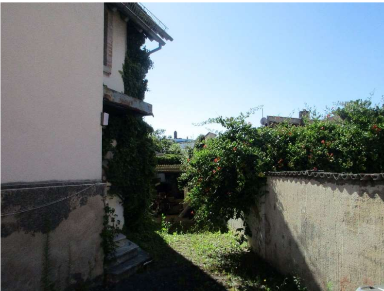
Hoffläche mit Überdachung vom Tor aus
