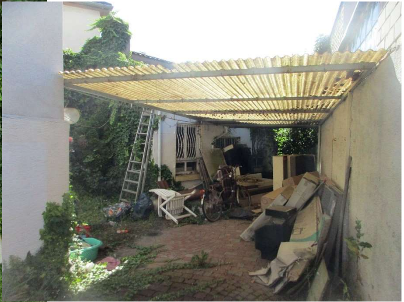
Hoffläche mit Überdachung, im Hintergrund Seitengebäude
