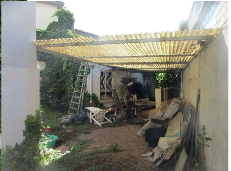
Hoffläche mit Überdachung, im Hintergrund Seitengebäude
