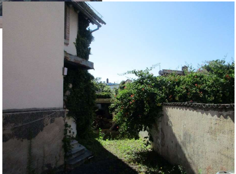
Hoffläche mit Überdachung vom Tor aus
