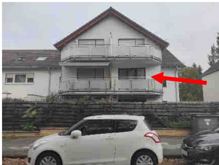
Bild 2: Südwestansicht zur Straße
