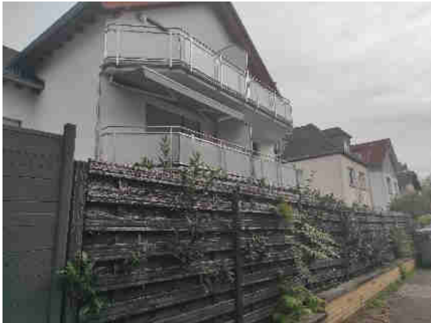
Bild 1: Ansicht entlang des Gehweges
