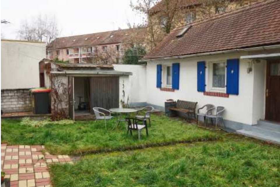
Bild 7: Ansicht des Bewertungsobjekts (Hinterhaus, Abstellraum)
