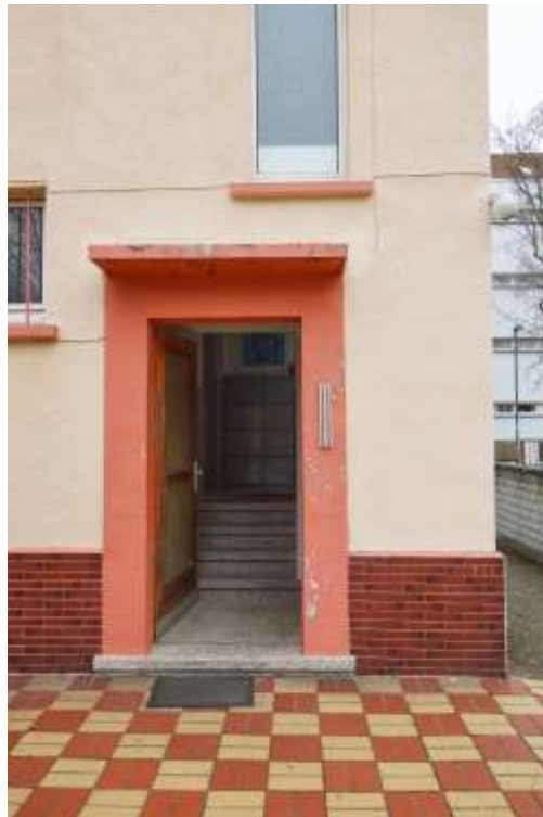
Bild 6: Ansicht des Hauseingangsbereichs
