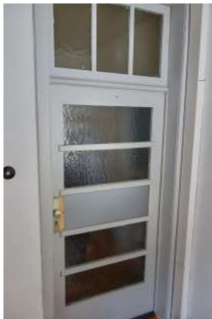
Bild 22: Ansicht Wohnungseingangstür (exemplarisch)
