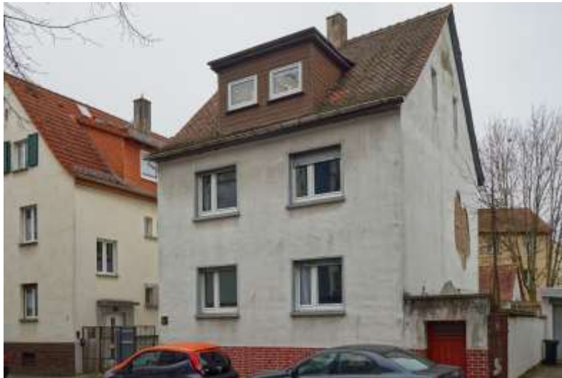
Bild 3: Ansicht des Bewertungsobjekts aus westlicher Richtung
