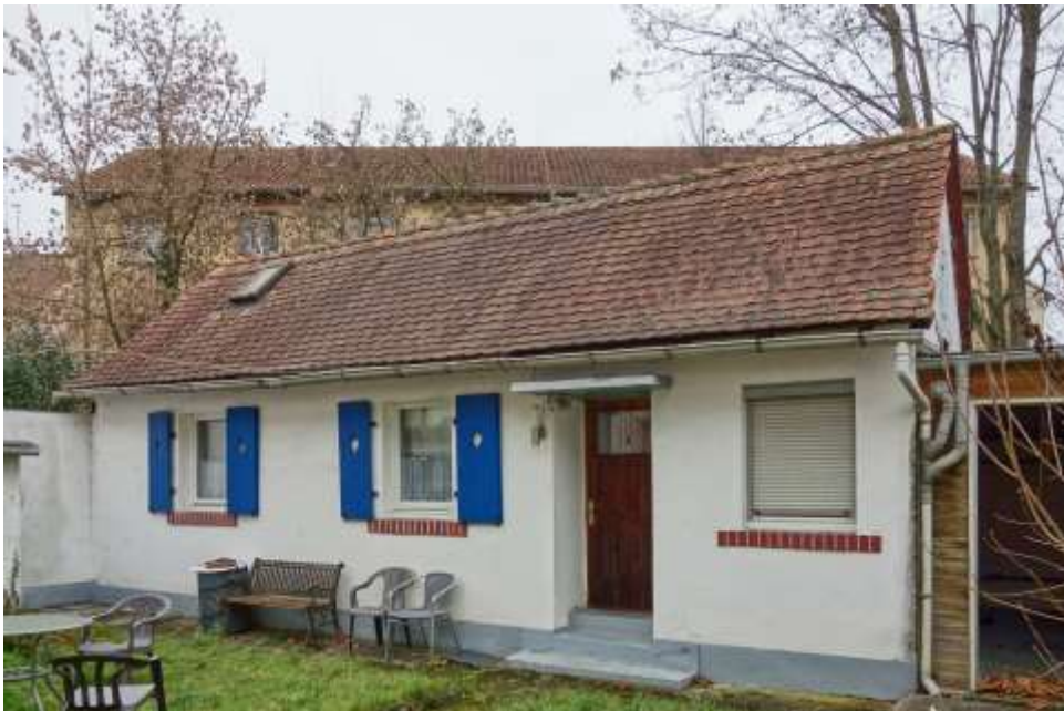
Bild 8: Ansicht des Bewertungsobjekts (Hinterhaus)
