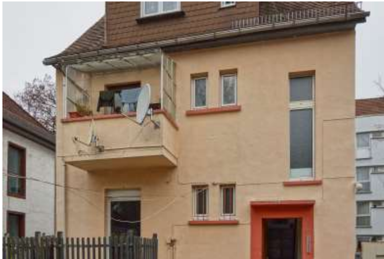
Bild 5: Ansicht des Bewertungsobjekts aus südöstlicher Richtung (Rückansicht)
