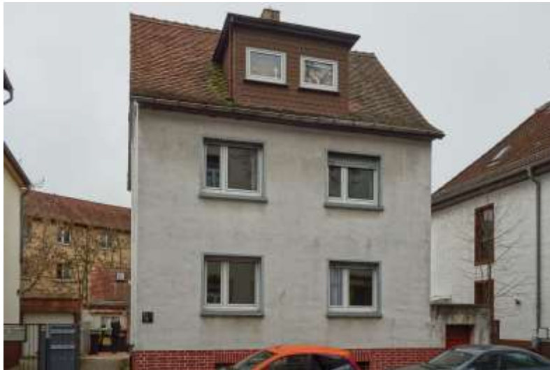
Bild 1: Ansicht des Bewertungsobjekts aus nordwestlicher Richtung
