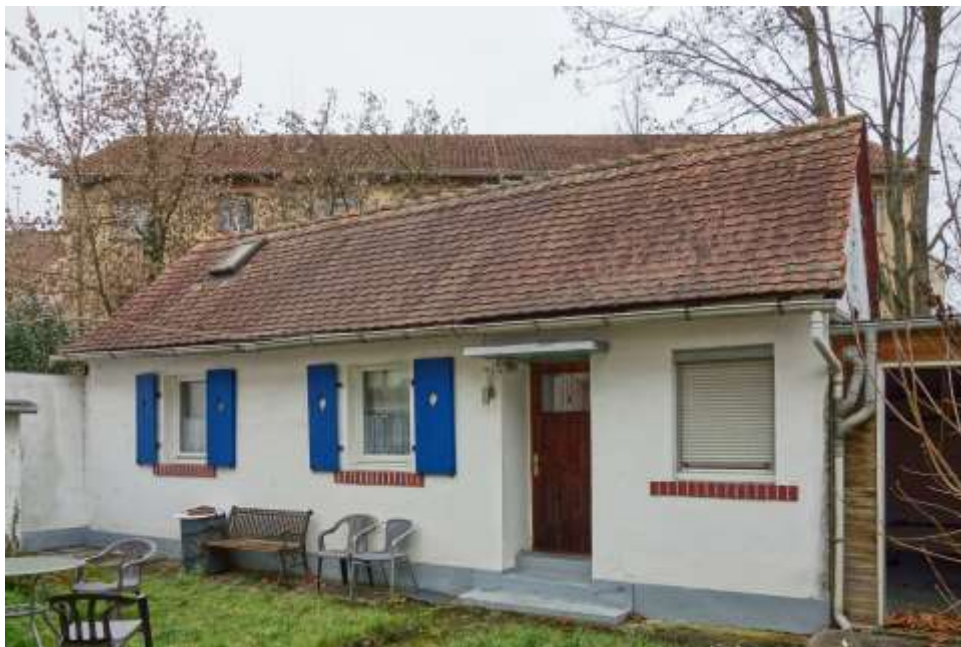
Bild 8: Ansicht des Bewertungsobjekts (Hinterhaus)
