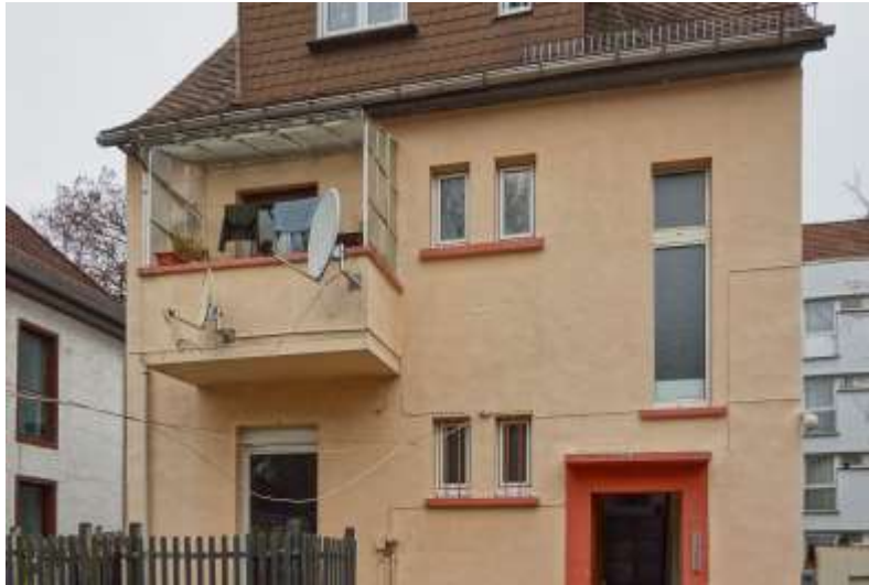
Bild 5: Ansicht des Bewertungsobjekts aus südöstlicher Richtung (Rückansicht)
