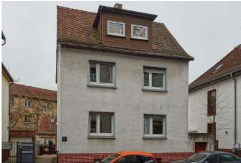
Bild 1: Ansicht des Bewertungsobjekts aus nordwestlicher Richtung
