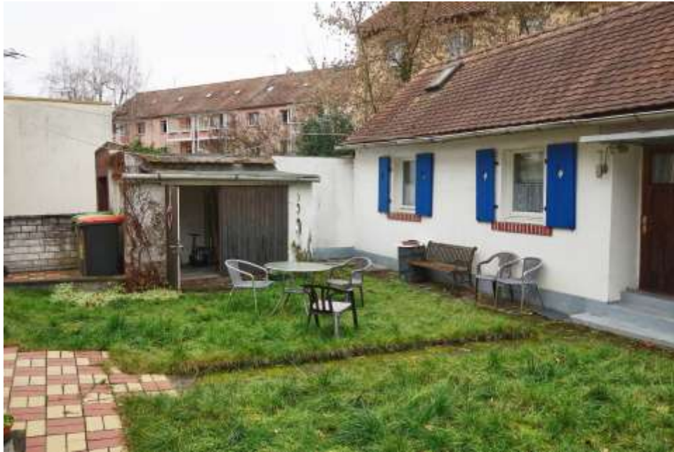
Bild 7: Ansicht des Bewertungsobjekts (Hinterhaus, Abstellraum)
