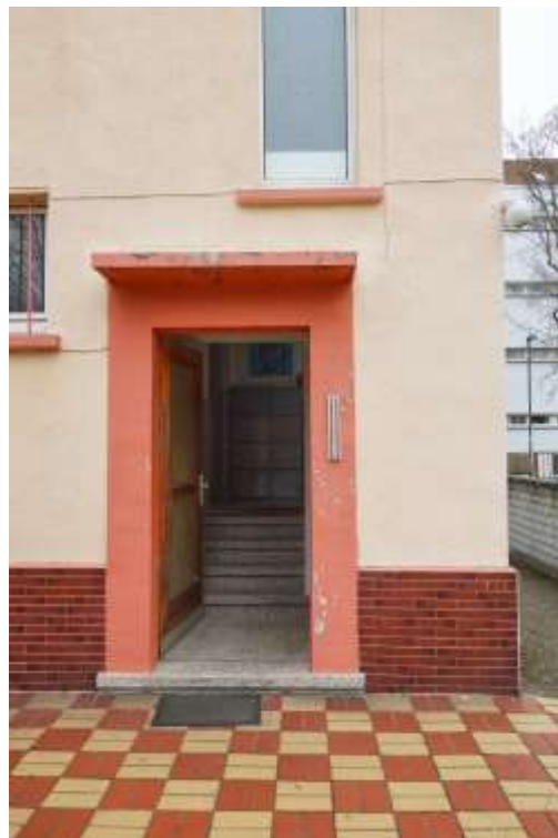
Bild 6: Ansicht des Hauseingangsbereichs
