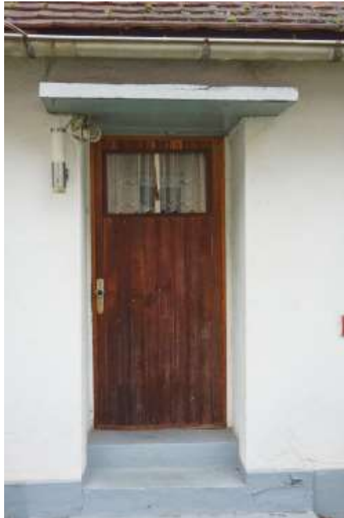
Bild 9: Ansicht des Hauseingangsbereichs (Hinterhaus)
