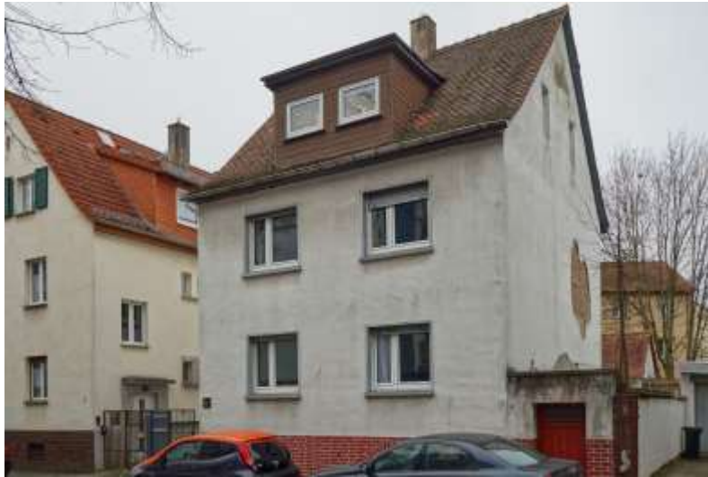
Bild 3: Ansicht des Bewertungsobjekts aus westlicher Richtung
