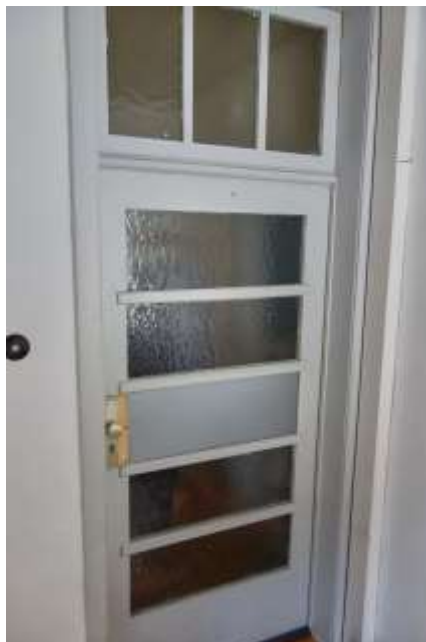
Bild 22: Ansicht Wohnungseingangstür (exemplarisch)
