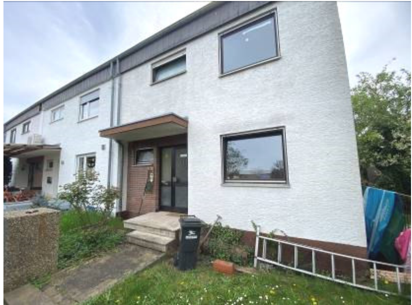
Foto 3 des SV: Gebäude-Ansicht von Nordwesten
