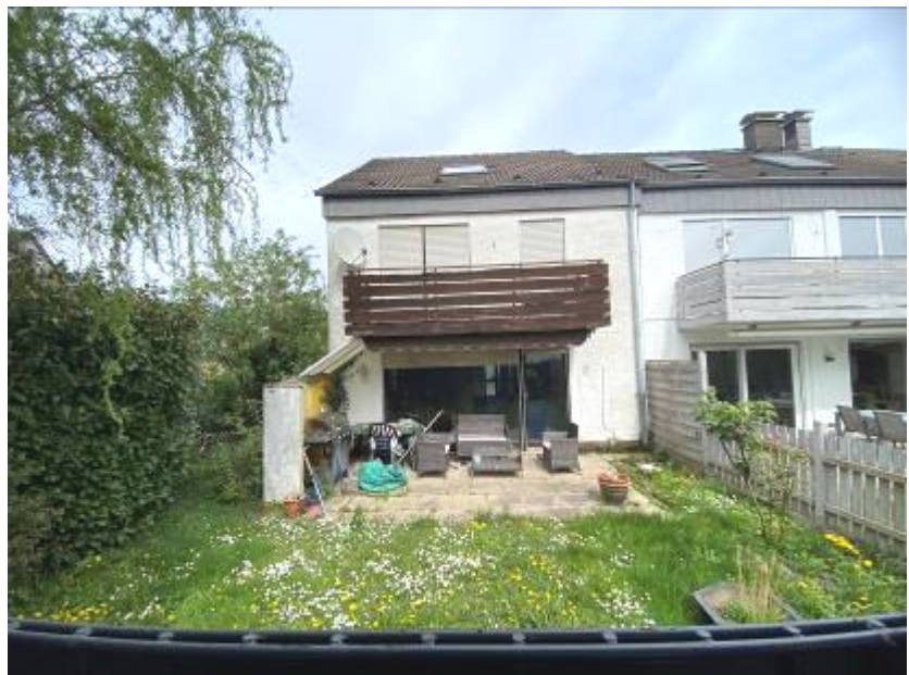
Foto 4 des SV: Gebäude-Ansicht von Süden, von Flurstück 888; Hausrückseite, Garten
