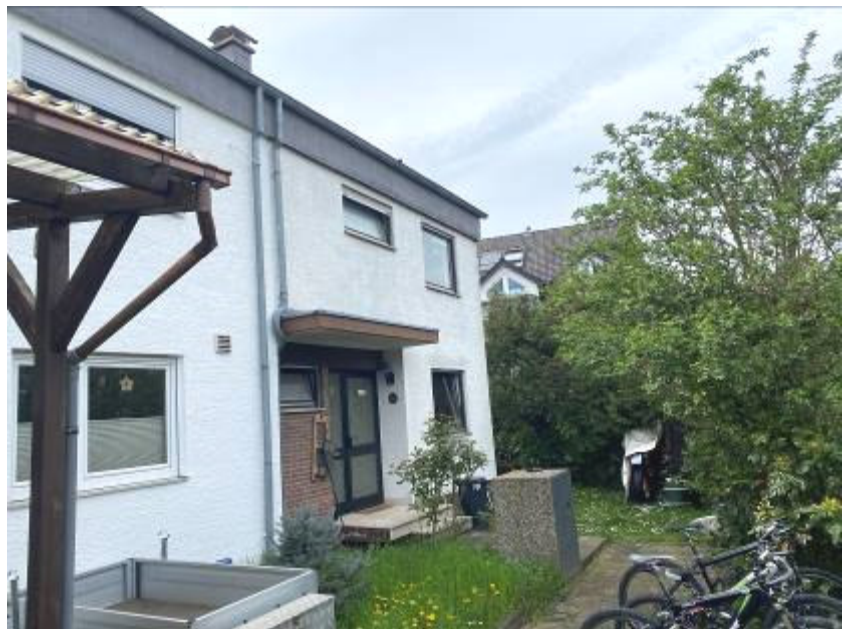
Foto 2 des SV: Gebäudeansicht Im Hainloch 6 F; Hauseingangsseite, Ansicht von Nordosten
