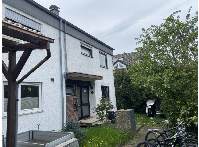
Foto des SV: Gebäudeansicht Im Hainloch 6 F; Hauseingangsseite, Ansicht von Nordosten
