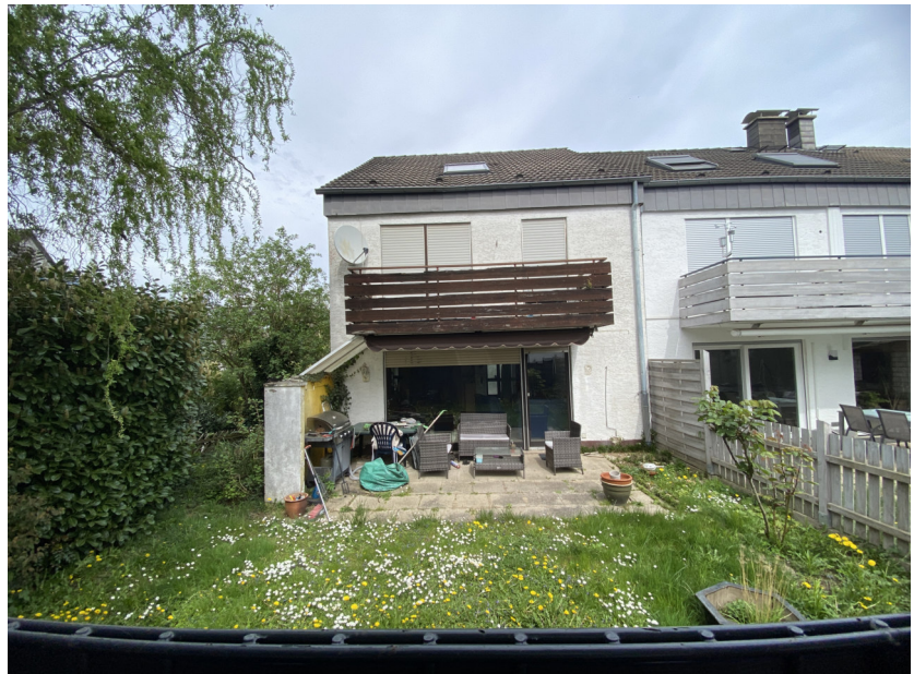
Foto des SV: Gebäude-Ansicht von Süden, von Flurstück 888; Hausrückseite, Garten
