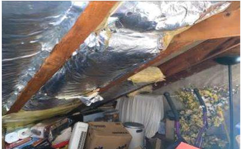
**Abb. 3:** Foto des SV; z.T. fehlende Zwischensparendämmung, z.T. schadhafte Dampfsperren
