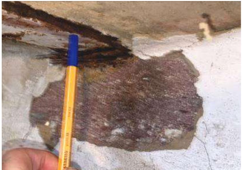
**Abb. 6:** Foto des SV; z.T. Korrosionen der Stahlträger an den Auflagerbereichen
