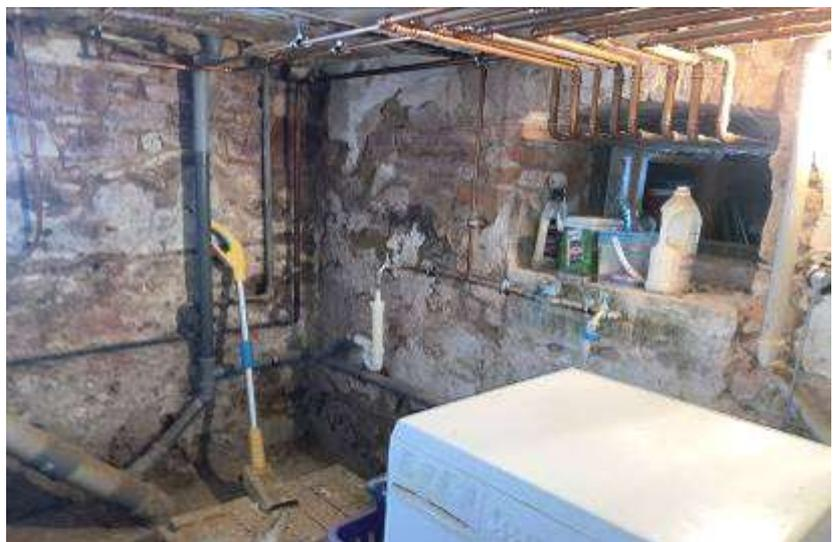
**Abb. 4:** Foto des SV; z.T. baujahrestypische Feuchtschäden und Absandungen der Kellerwände (KG)
