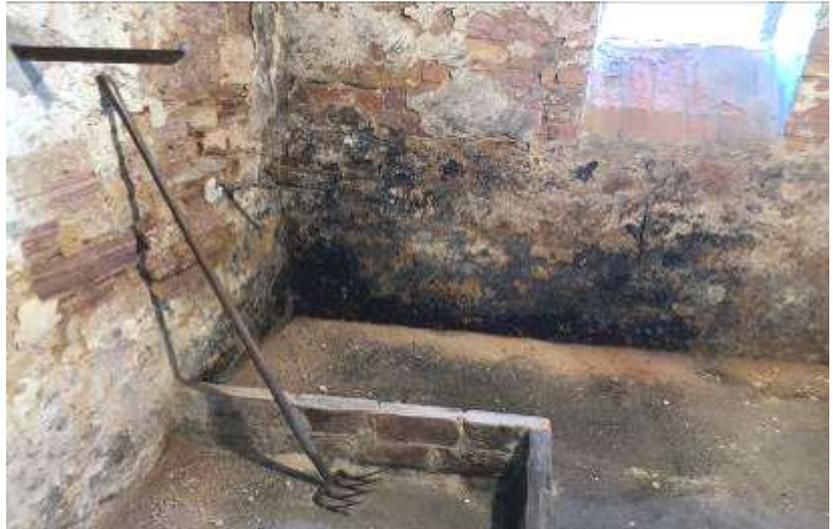
**Abb. 5:** Foto des SV; z.T. baujahrestypische Feuchtschäden und Absandungen (KG)
