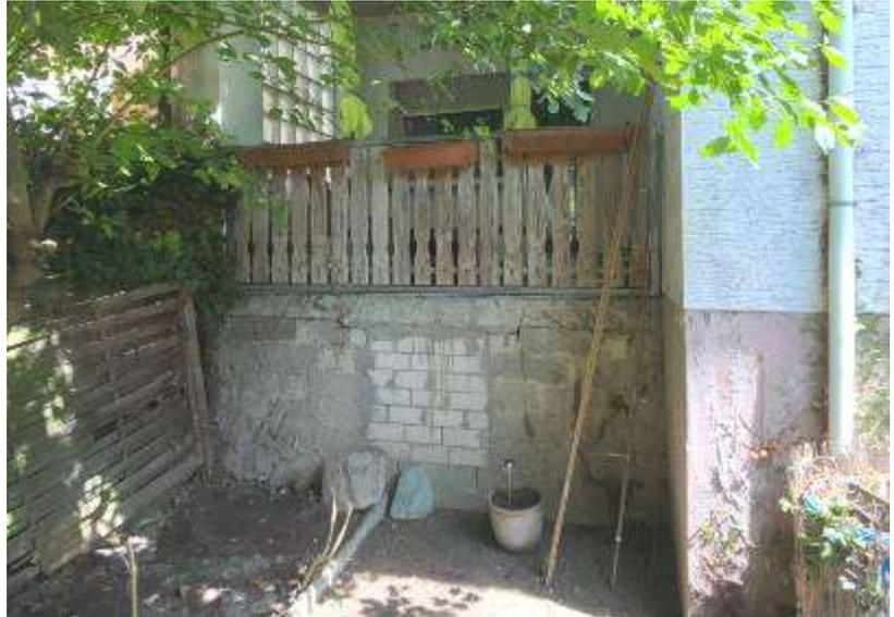
**Abb. 2:** Foto des SV; z.T. Fassade schadhaft (fehlender Verputz)
