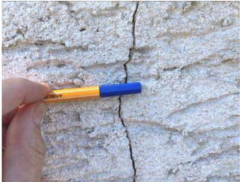
Abb. 1: Foto des SV; z.T. Fassade schadhaft (Putzrisse)
