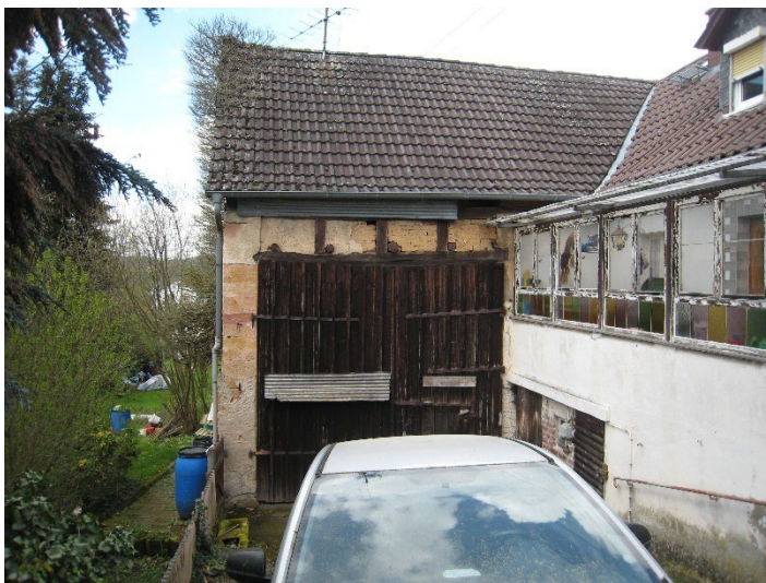
Foto Nr. 3, Hof mit Nebengebäude u. Überdachung/Windfang.
