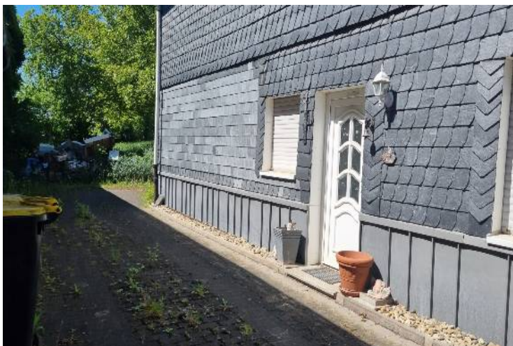
Bild 2: Zugang zum Untergeschoss über den Hof
