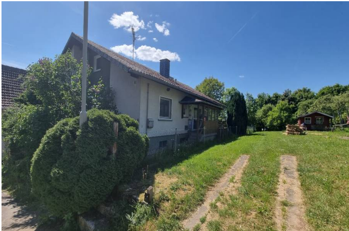
Ansicht von der Straße aus, oberhalb des Gebäudes.
