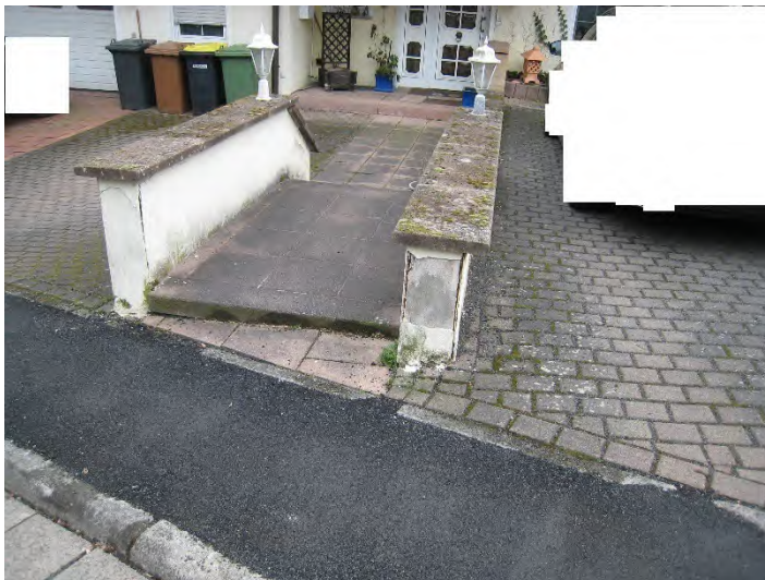
Bild Nr. 8, Eingangsbereich zur Wohnung im EG, mit Putzabplatzungen am Mauerwerk.
