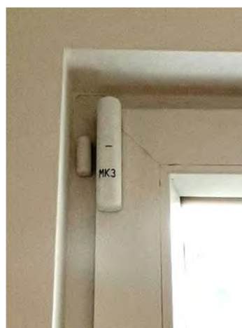
10 E + 11 E – Kind 2 mit Magnetsicherung an Fenster
