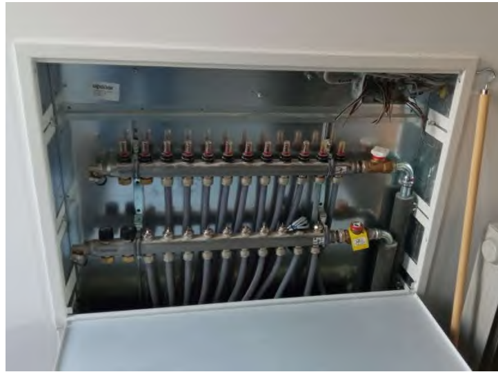
01 E + 02 E – Flur mit Verteilung Fußbodenheizung
