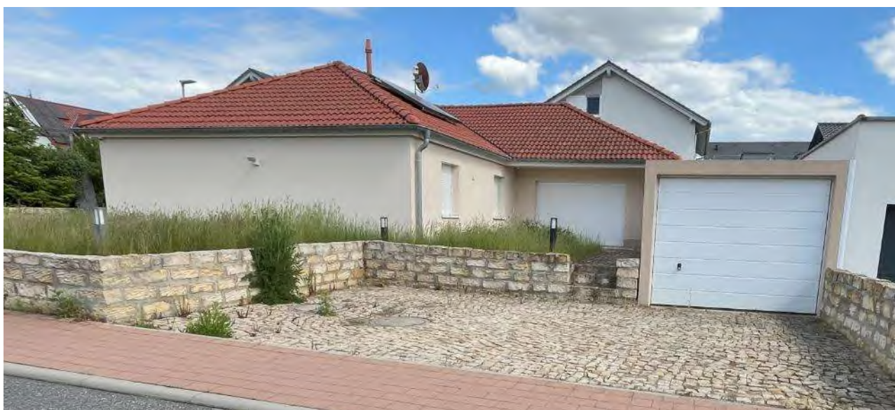
04 – Straßenansicht von Nordwesten
