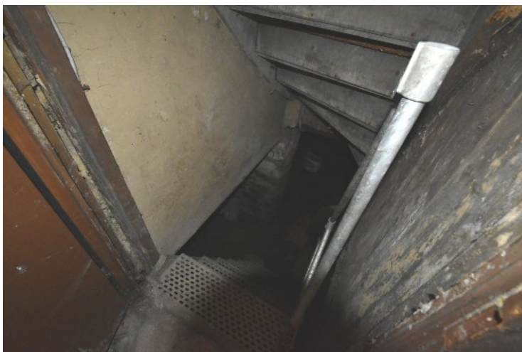
Bild 3: Treppe zum Keller
