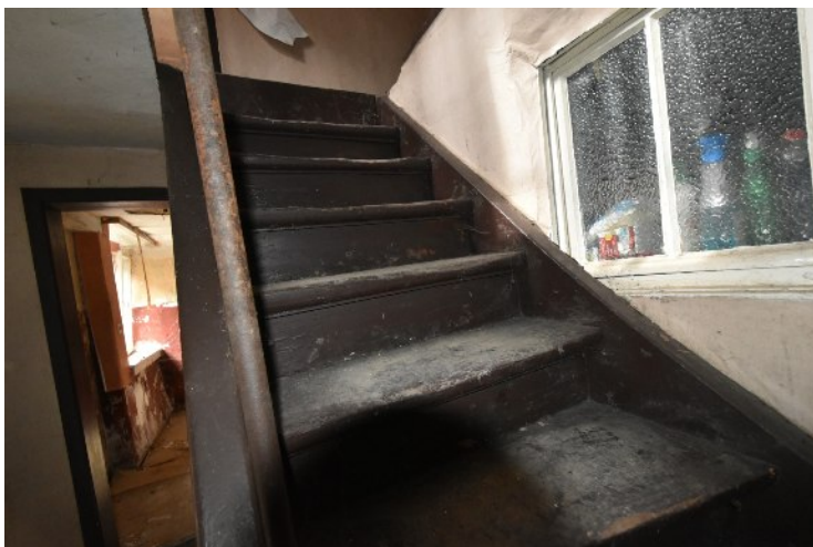
Bild 6: Treppe zum Obergeschoss
