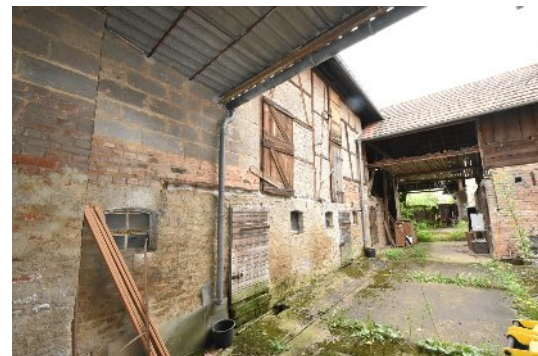
Bild 2: Nebengebäude u. Scheune
