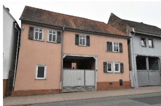
Bild 1: Ansicht von der Straße
