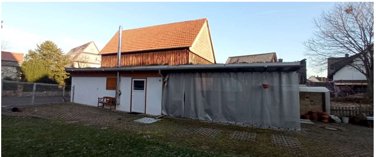
04 – Seitenansicht Garage und Carport
