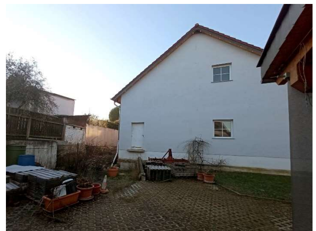
06 – Brandwand Scheune Haus Nr. 10
