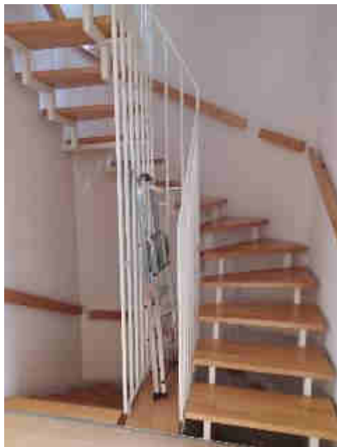
Bild 9: Treppe zum Dachgeschoss
