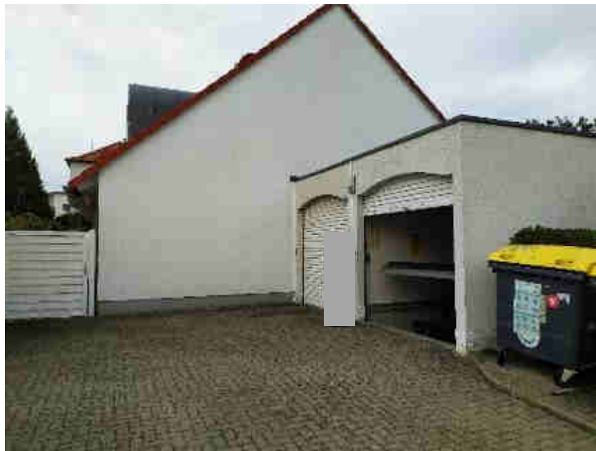
Bild 2: Garagenhof mit Doppelparker Nr. 19 unten
