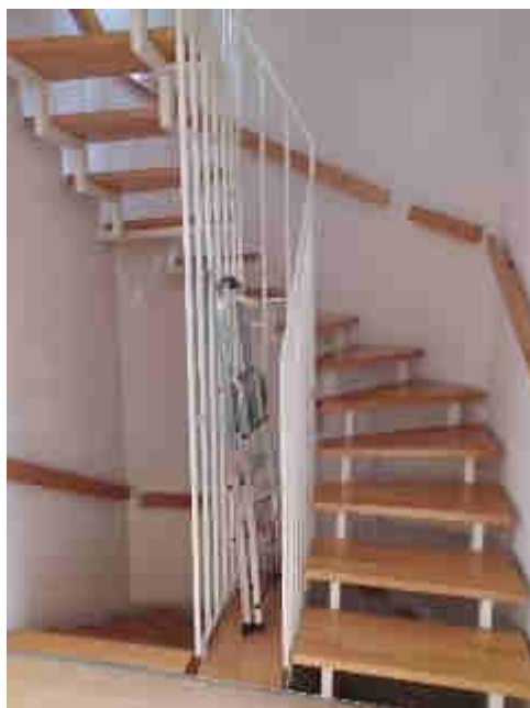
Bild 9: Treppe zum Dachgeschoss
