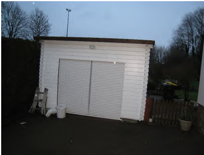
Bild Nr. 4, Garage
