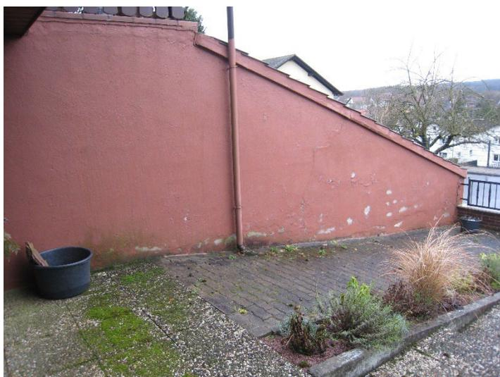
Bild Nr. 7, Stützmauer mit Rissen und Farbabplatzungen.
