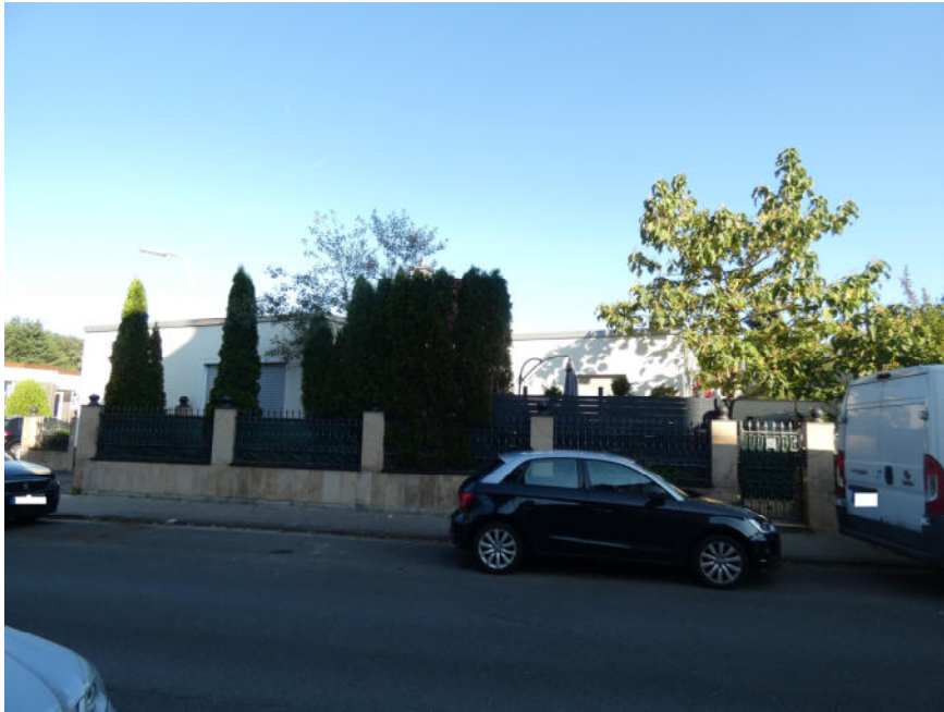
Foto 2: Straßenansicht, Ansicht Nachtigallenstraße
