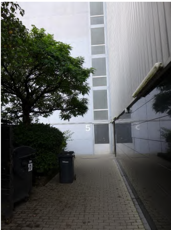
4 Zugang Dreieichstraße 5, Ecke Talstraße 5
