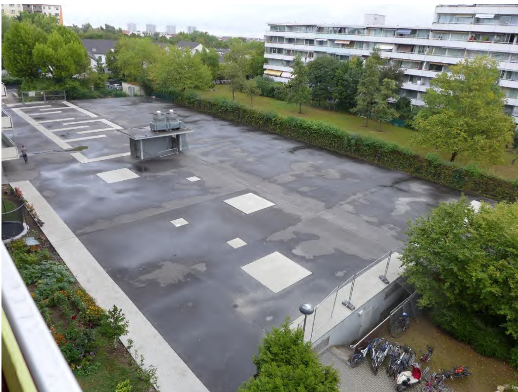
10 Blick von Loggia zu Außenanlagen, Tiefgaragendach (derzeit Arbeiten)
