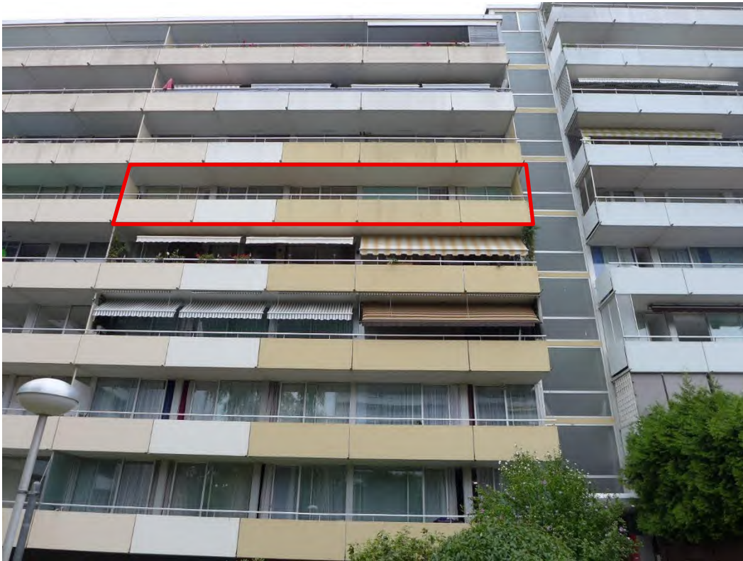
7 Hofansicht Talstraße 5, Lage des Bewertungsobjekts markiert
