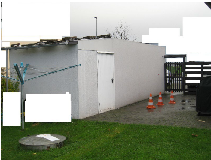
Bild Nr. 5, Rückansicht der Garage mit Gastank
