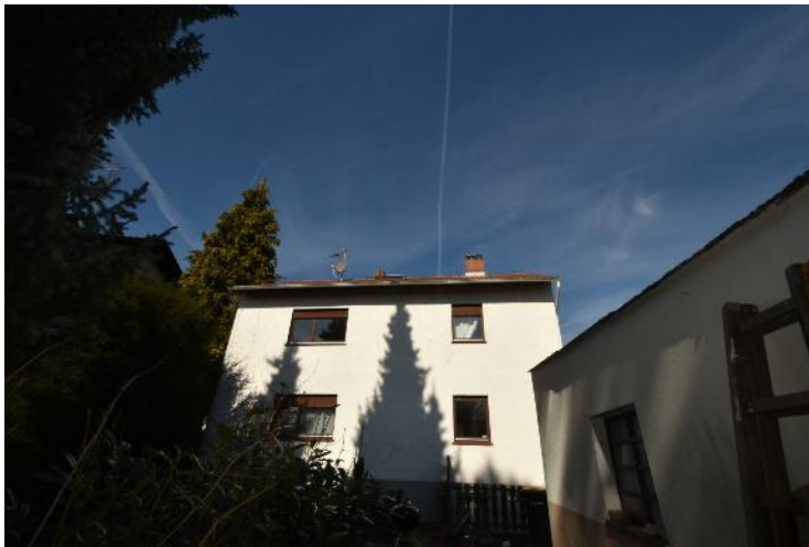
Bild 1: Ansicht der Gebäuderückseite
