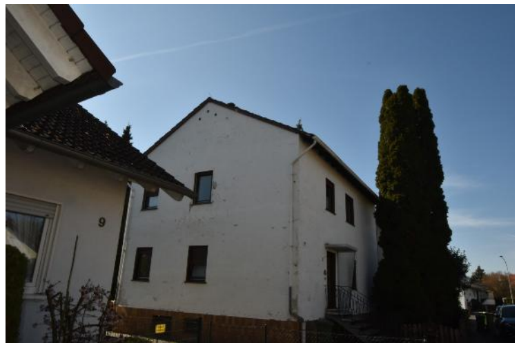
Wohnhaus – Straßen- u. Seitenansicht
