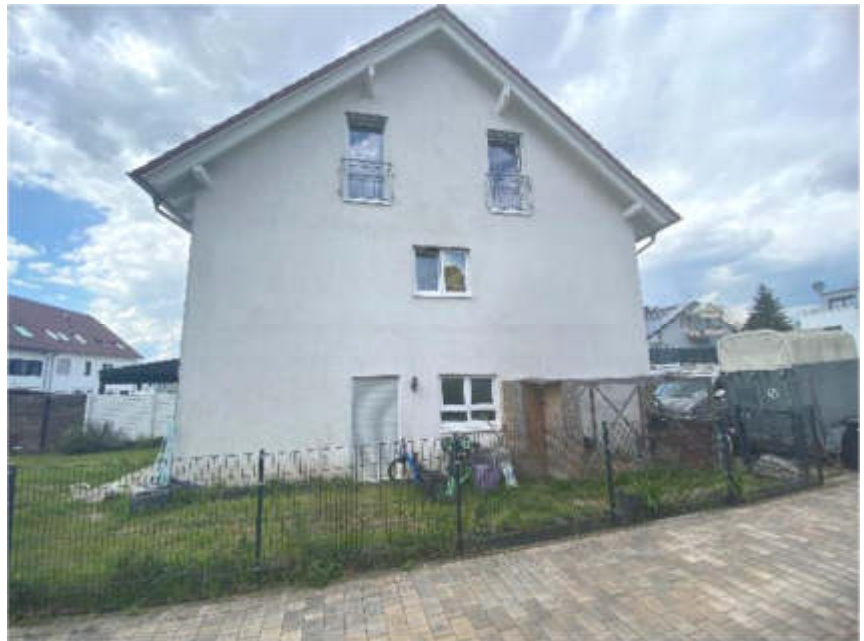
Foto 3 des SV: Ansicht von Osten
