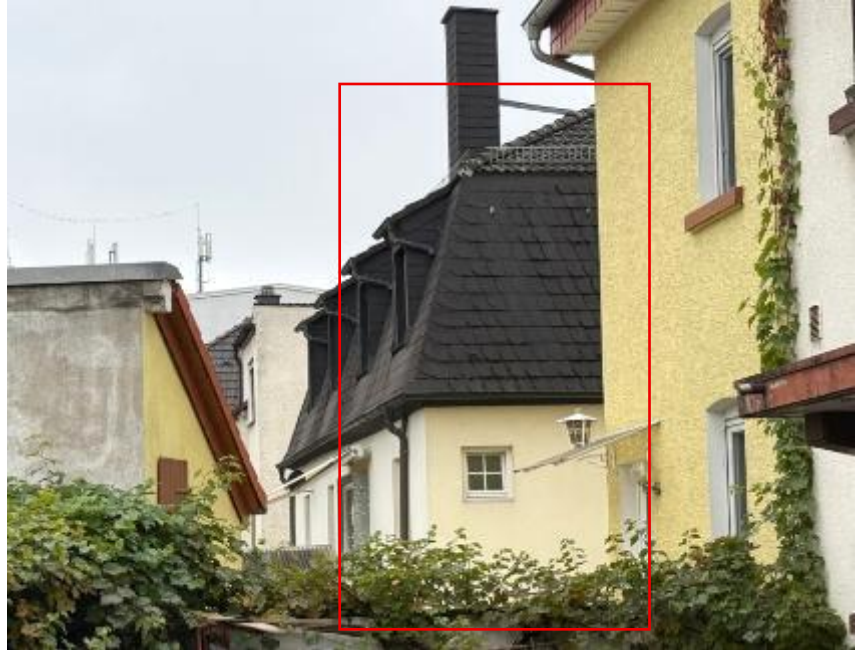
Foto 3 des SV: Doppelhaushälfte Frankfurter Straße 73, Ansicht von Nordosten, Rotmarkierung d.d. SV
