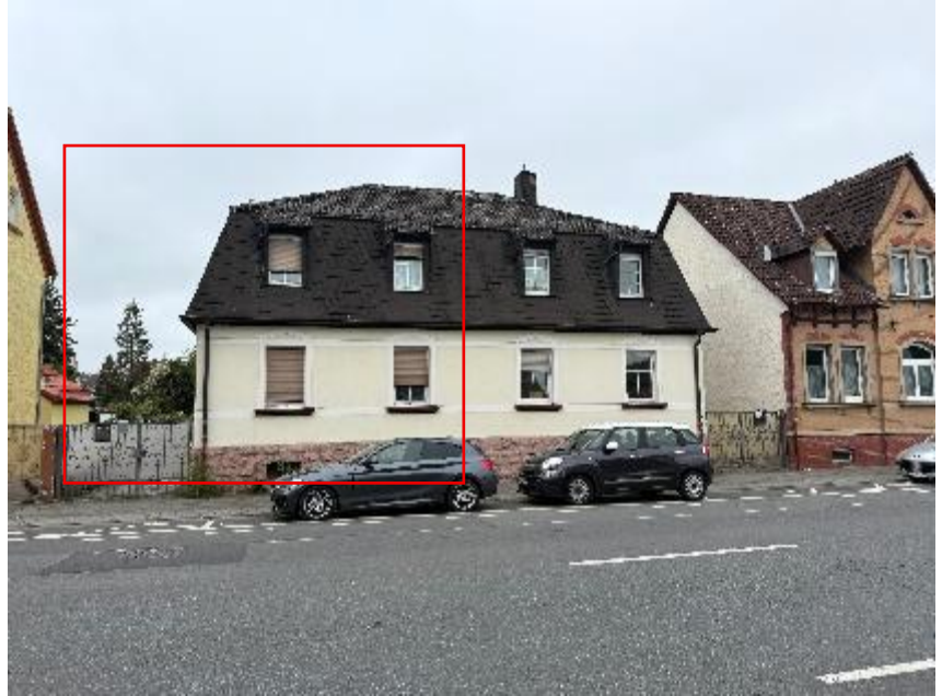
Foto 1 des SV: Doppelhaushälfte Frankfurter Straße 73 in Dreieich-Sprendlingen, Ansicht von Westen; Rotmarkierung d.d. SV
