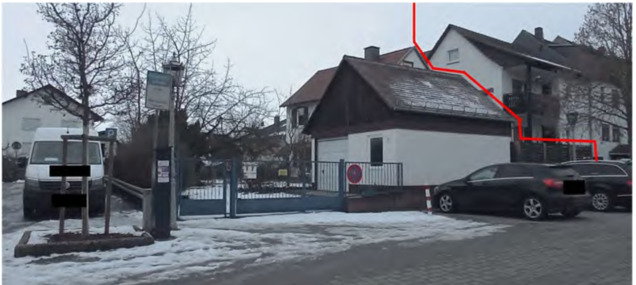
09 – Straßenansicht von Osten
