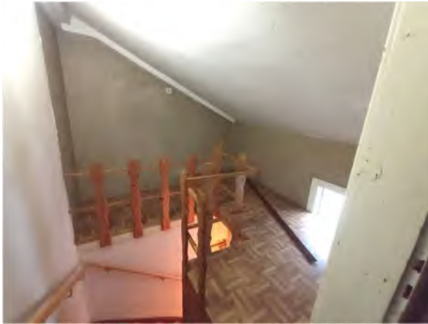
21 – Treppenflur im Anbau
