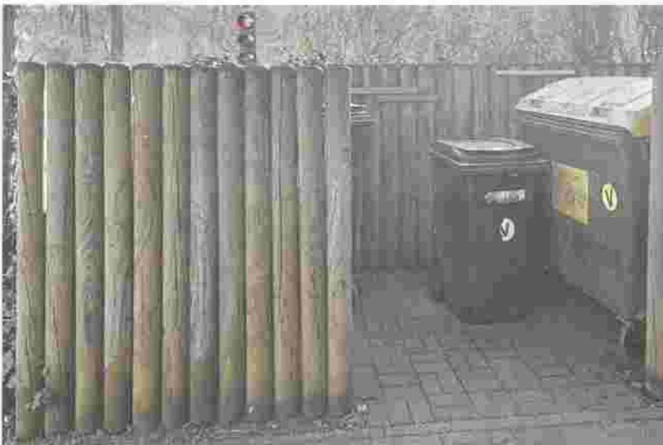
Bild 6: Ansicht der Mülltonnenstellplätze
