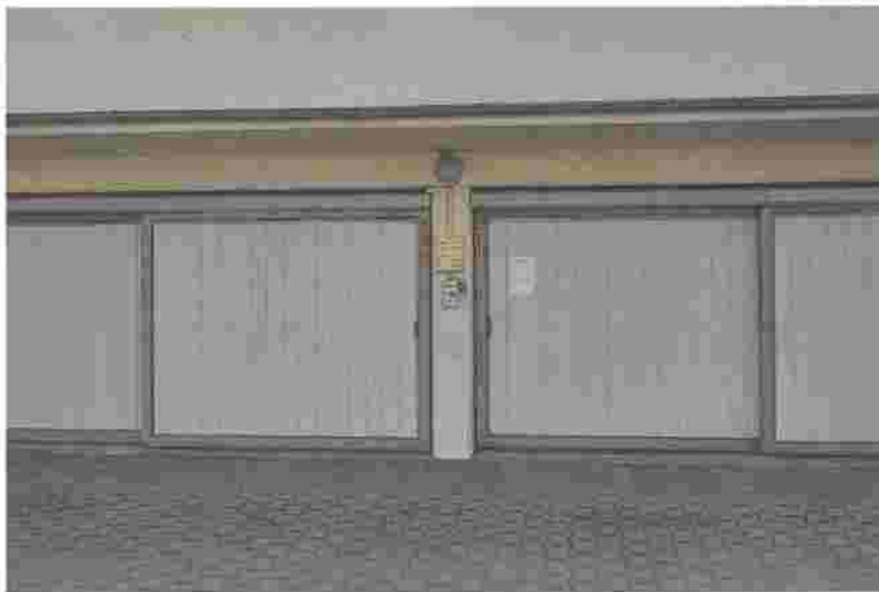
Bild 11: Ansicht der Garagenstellplätze
