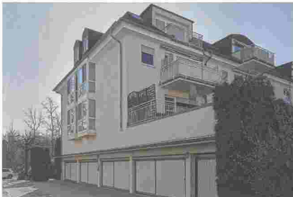
Bild 10: Ansicht der Garagenstellplätze
