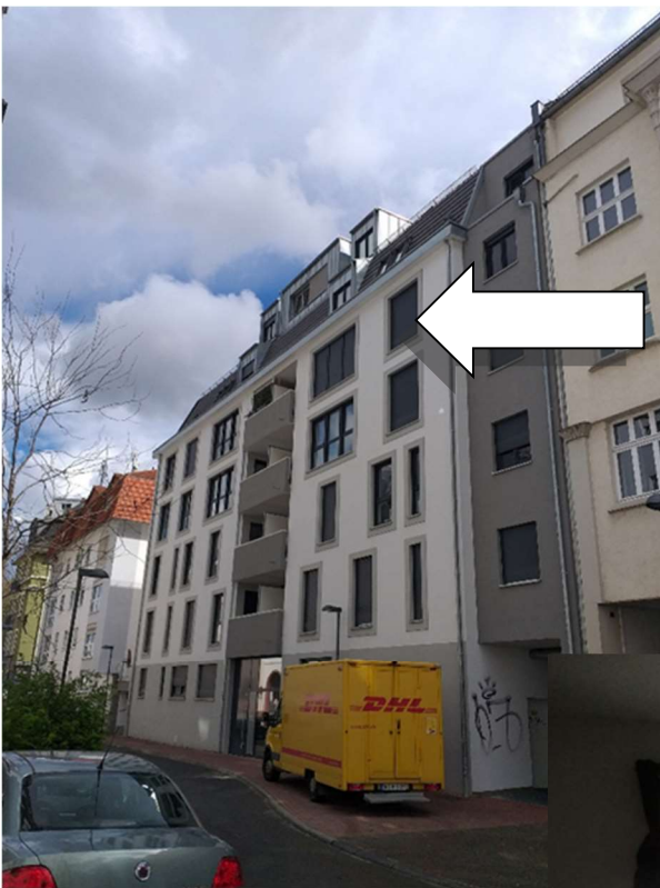
Haus Nr. 56 Straßenansicht
