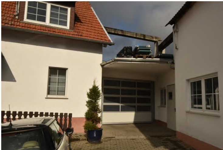
Bild 4: Zwischen Wohnhaus und dem Nebengebäude
