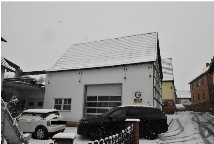
Bild 5: Nebengebäude Ansicht Hof
