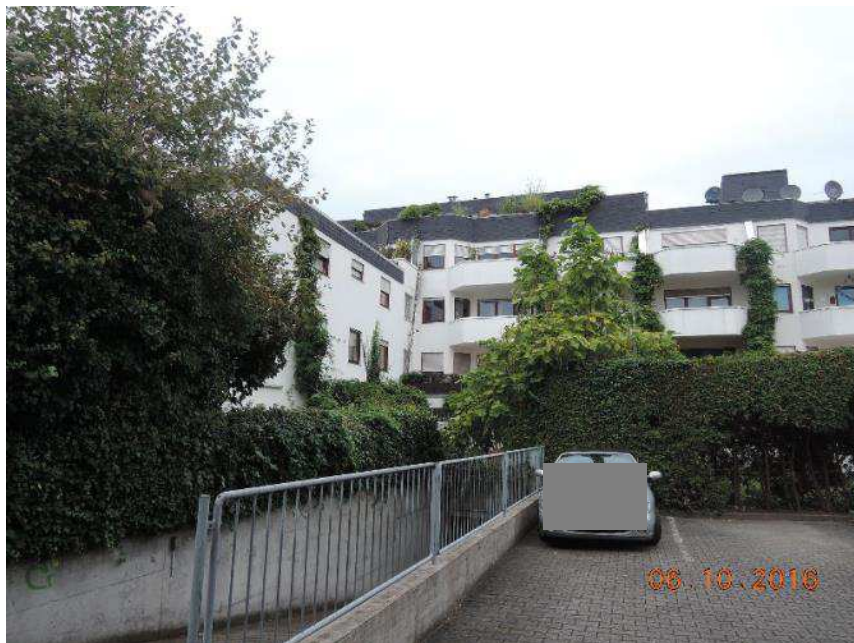
Bild 10: Rückansicht des Gebäudes mit Einfahrtsrampe zur Tiefgarage
