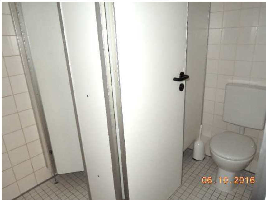
Bild 6: Toiletten (Foto von 2016)
