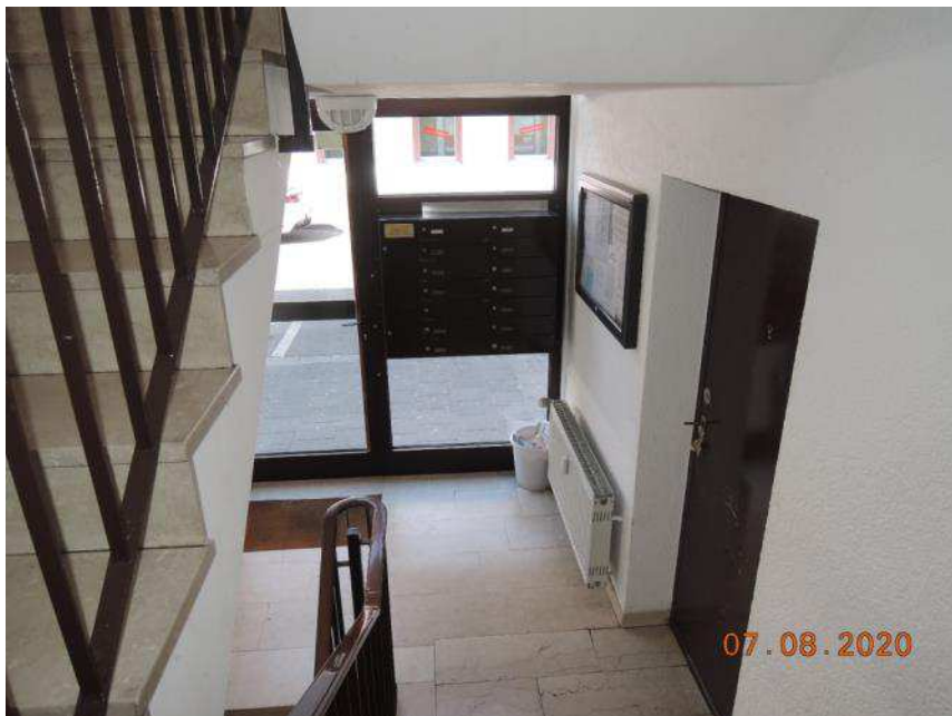
Bild 2: Hauseingang und Treppenhaus
