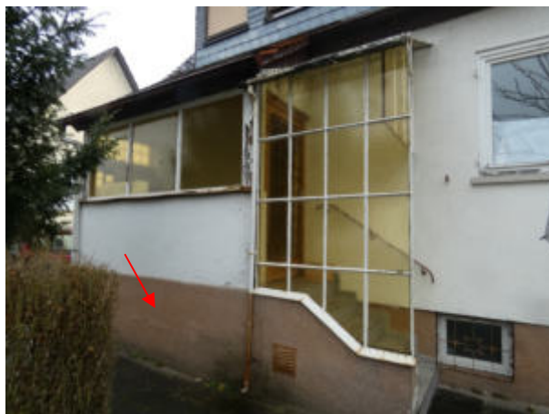
Feuchtigkeitsschäden, Sockel
