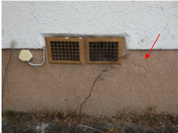
Feuchtigkeitsschäden, Sockelbereich
