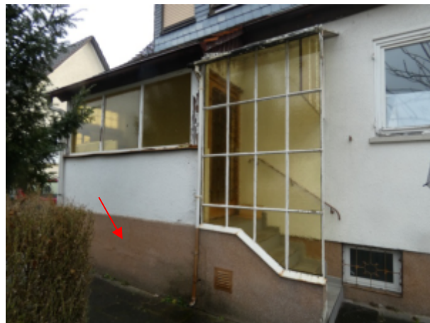
Feuchtigkeitsschäden, Sockel
