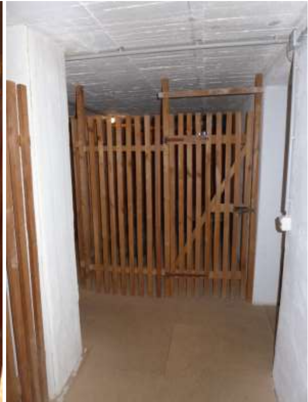
11 b Abstellräume Dachboden
