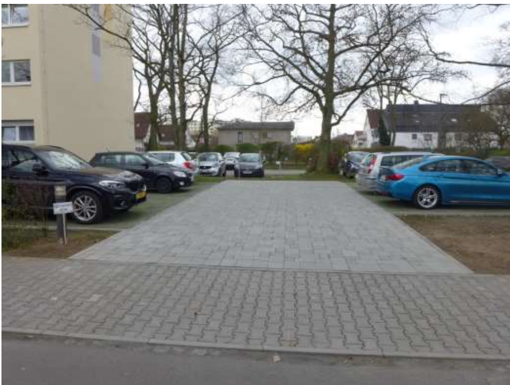
6 neu angelegte Stellplatzfläche
