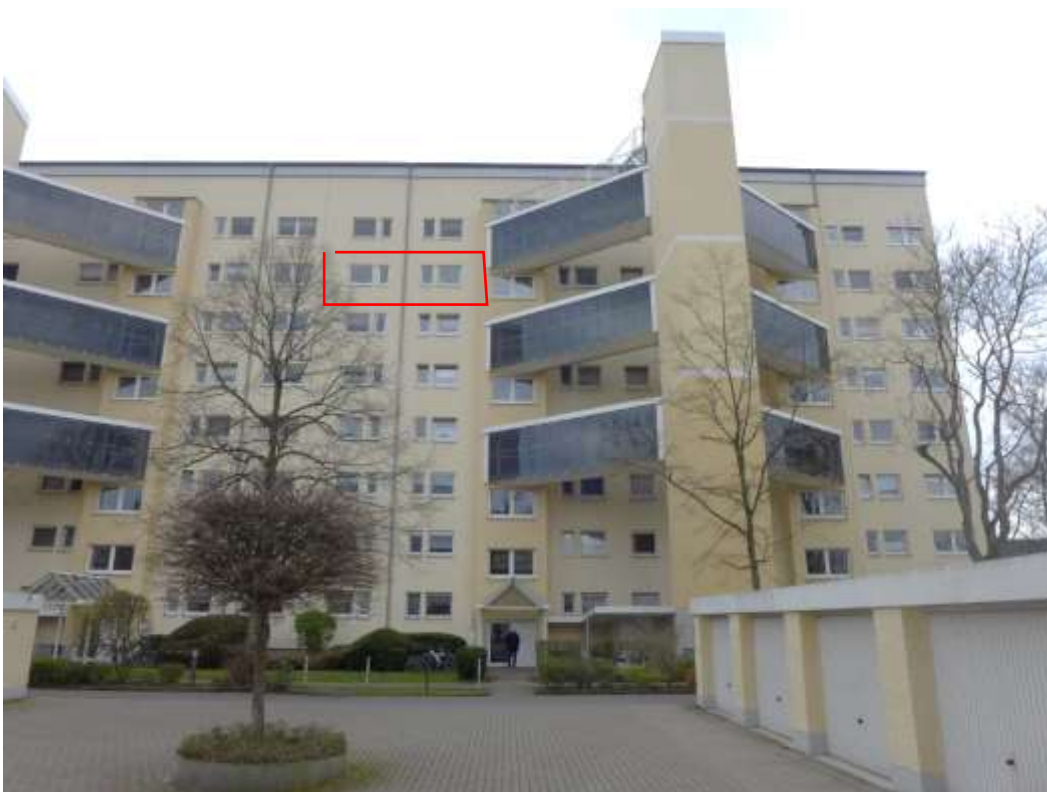
8 Rückansicht (Zugangsseite), Lage Bewertungsobjekt
