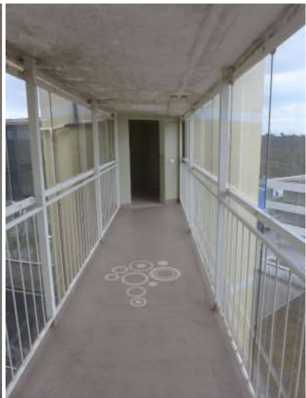
10 b Zugang zum Aufzugsschacht
