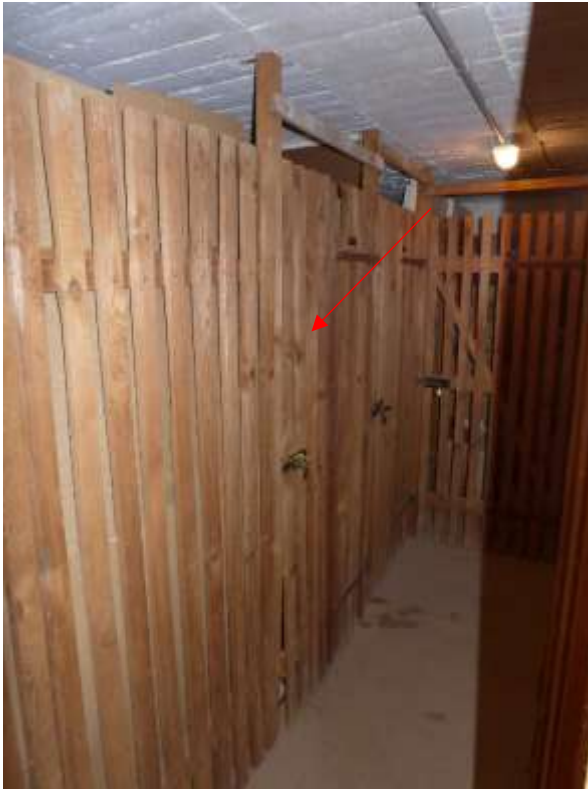
11 a Abstellräume Dachboden
